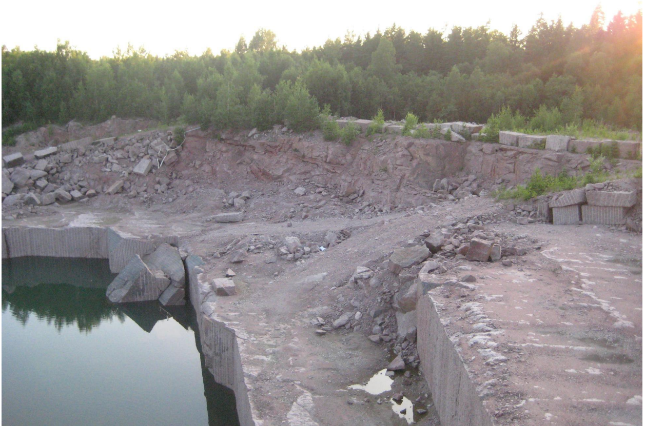
Kuva 4. Keskimäärin vain 10-30 prosenttia irrotetusta kivistä voidaan jalostaa blokeiksi (Ympäristöministeriö 2001). Ylijääneestä sivukivistä voidaan louhimon jälkihoidon yhteydessä rakentaa turvallisia ja kestäviä esteitä putoamisvaaran poistamiseksi.
