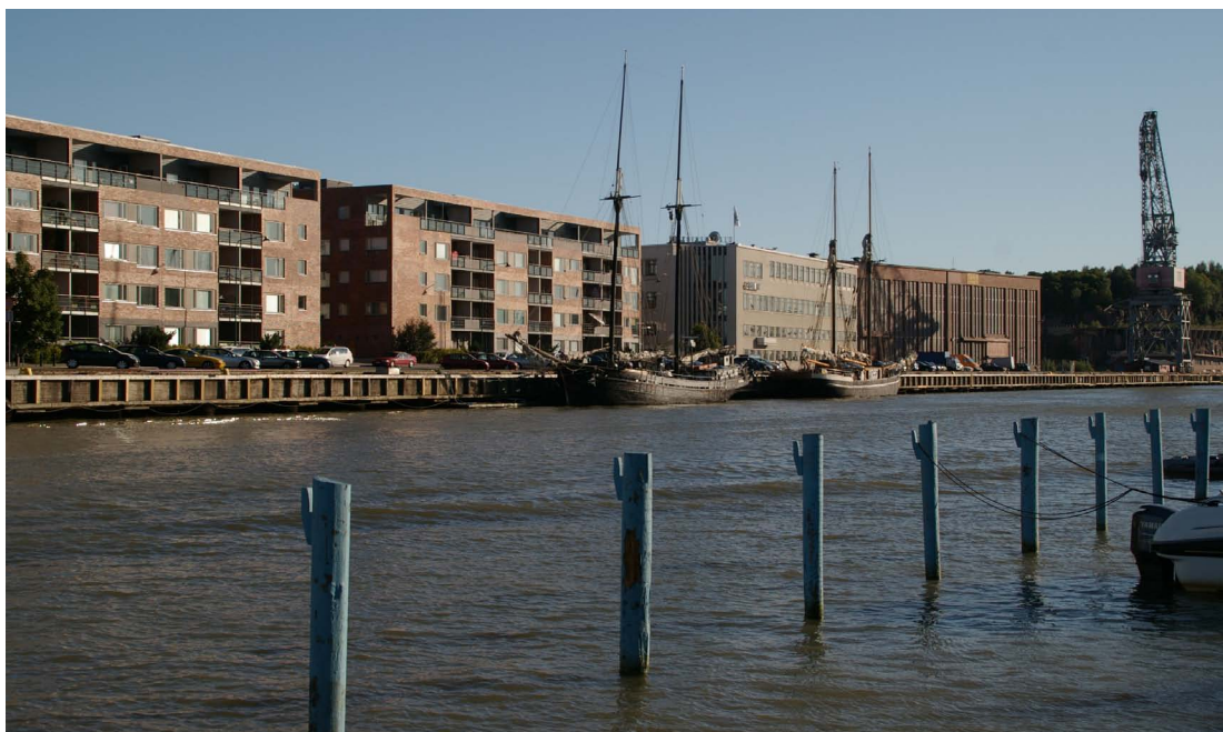
Asennushalli nähtynä läntiseltä rantakadulta, pohjoisesta.
