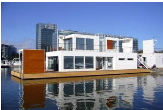
Kuva 26: Tilaelementeistä koottu kelluva rakennus.
