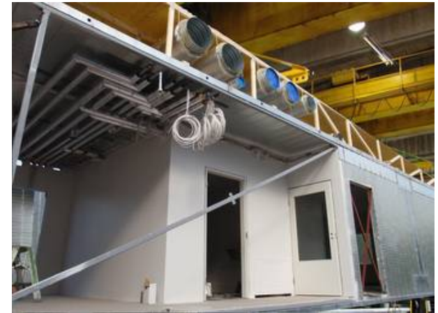
Kuva 28: Myös tilaelementtirakentamisessa voidaan huomioida erilaiset tekniset asennukset ja osien kytkeminen laajemmiksi kokonaisuuksiksi. Asennukset tehdään jo tehtaalla.
