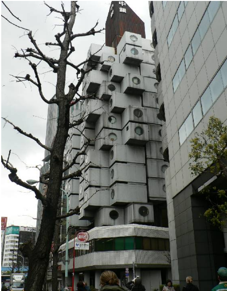
Kuva 11: Kisho Kurokawa, Nakagin Capsule Tower. Rakennus on erillisten tilamoduulien muodostama kokonaisuus.
