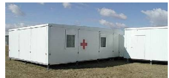
Kuva 25: Tilaelementtirakentaminen soveltuu hyvin nopeaa toimitusta ja siirrettävyyttä vaativiin projekteihin. Tällaisia ovat esimerkiksi katastrofitilanteisiin suunnitellut sairaanhoito- ja majoitusyksiköt.
