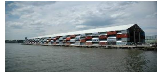
Kuva 22: Shigeru Ban, Container Museum. Museo on esimerkki, jossa kuljetukseen tarkoitettu kontti synnyttää siirrettävää arkkitehtuuria.
