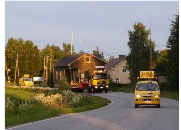
Kuva 36: Kokonaisen rakennuksen siirtäminen. Siirtämisessä on otettava huomioon ympäristön rajoitukset ja erilaiset turvamääräykset.
