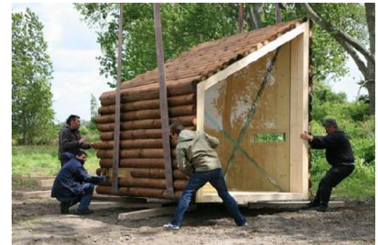
Kuva 1: Yleensä tilaelementti on sivuiltaan rajattu kappale.
