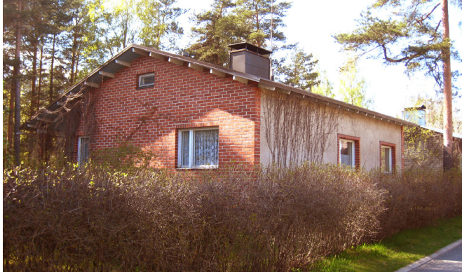
1960-luvun alussa tiili yleistyi puun rinnalla rakennusmateriaalina. 1960–1980 -lukujen tiilitaloja Tykissä. AK.
