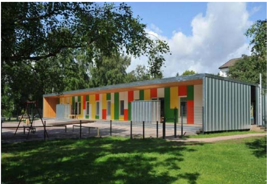
2008 valmistunut paviljonkipäiväkoti Silkkiuikku Helsingin Lauttasaassa on siirrettäväksi suunniteltu 11 tilaelementistä koostuva rakennus. Tämän ja kuuden muun kaupungin tilaaman tilaelementtipäiväkodin arkkitehti on Seppo Häkli.
