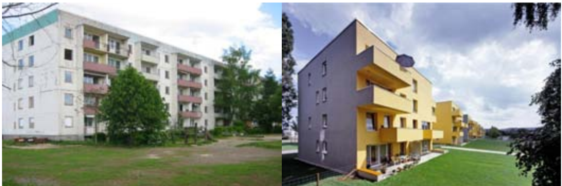
Einsteinstraße 9-37. Valmistunut 2004. Kustannukset 1 031€/m 2 . 200 metriä pitkä lamellitalo muuttui kahdeksaksi itsenäisesti seisovaksi kaupunkivillaksi.
