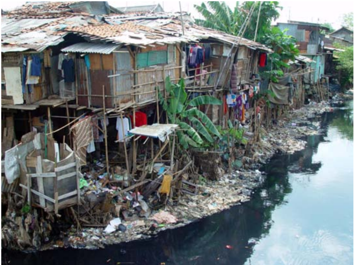
Jättemateriaaleista rakennettuja koteja Indonesian pääkaupungin Jakartan slummissa. (Kuvaaja Jonathan McIntosh. Lähde Wikimedia Commons, commons.wikimedia.org)
