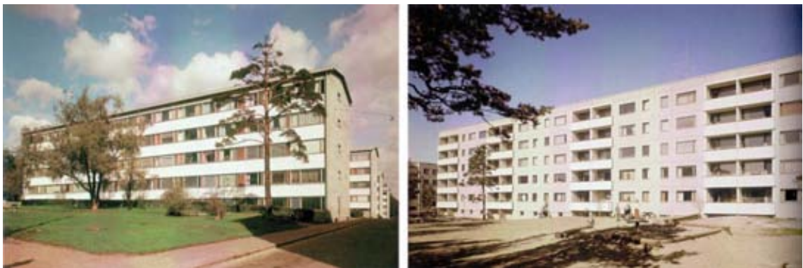
Nauhaelementtijulkisivu 1960-luvulta, ruutuelementtijulkisivu 1970-luvulta (Tehdään betonista 2009).
