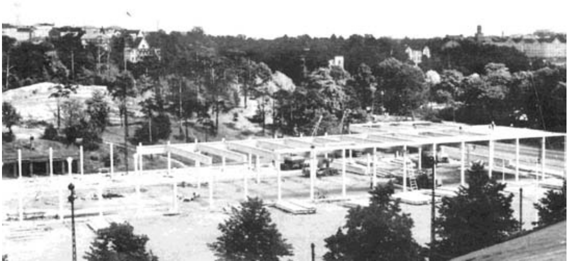
Turkuun sittemmin siirretty betonielementtirakenteinen Kansojen halli rakennusvaiheessaan Helsingin Töölönlahdella (Betonirakenteiden ympäristövaikutukset 1998).
