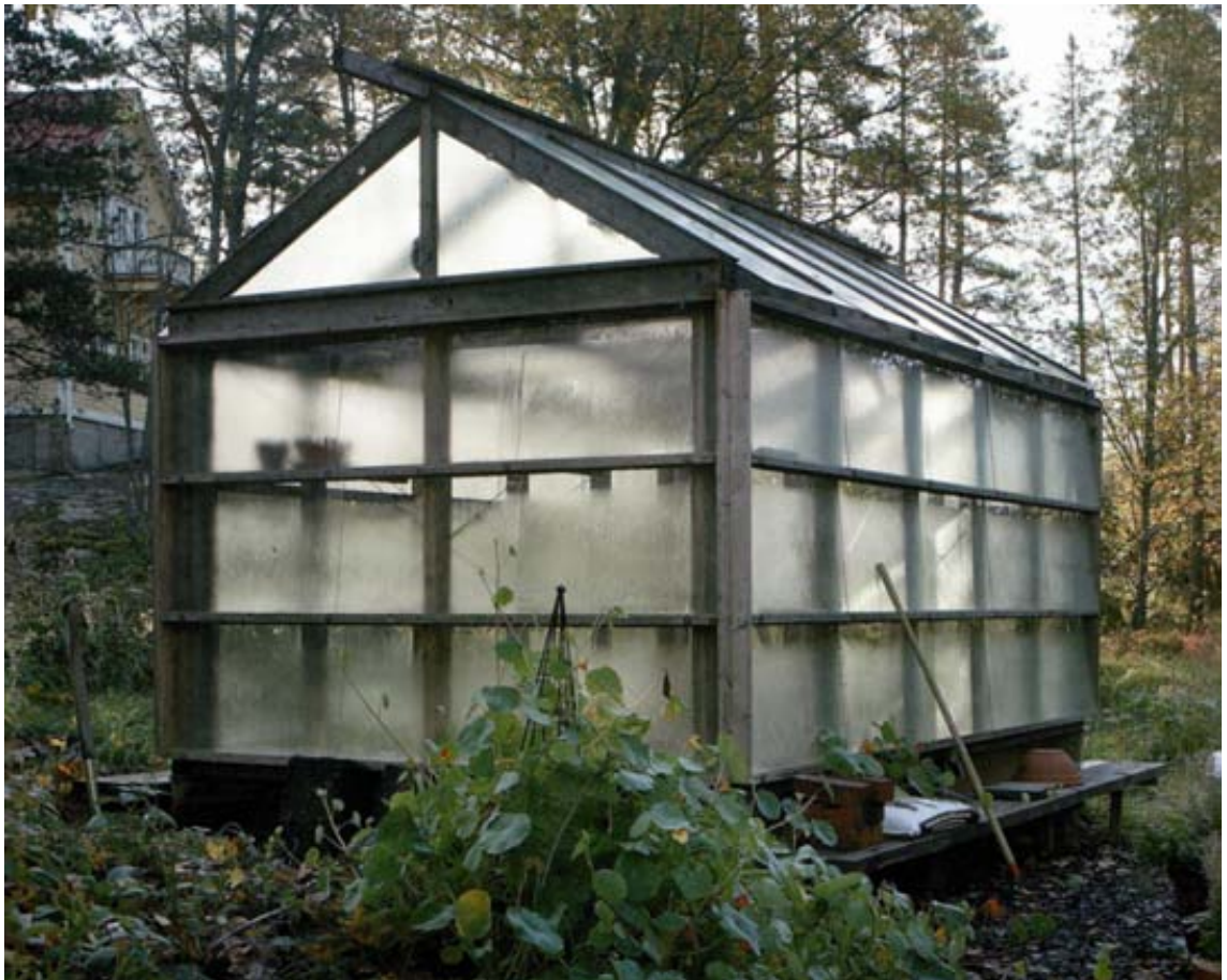
Jätelasista rakennettu kasvihuone Kirkkonummella, arkkitehti Anders Adlercreutz. Lasien limittyminen mahdollistaa vaihtelevan levyisten lasien käytön pienellä hävikillä. (Adlercreutz 2007).
