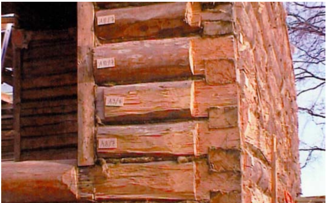
Siirtoa varten numeroitu hirsikehikko (Tuppurainen ja muut 2003b).
