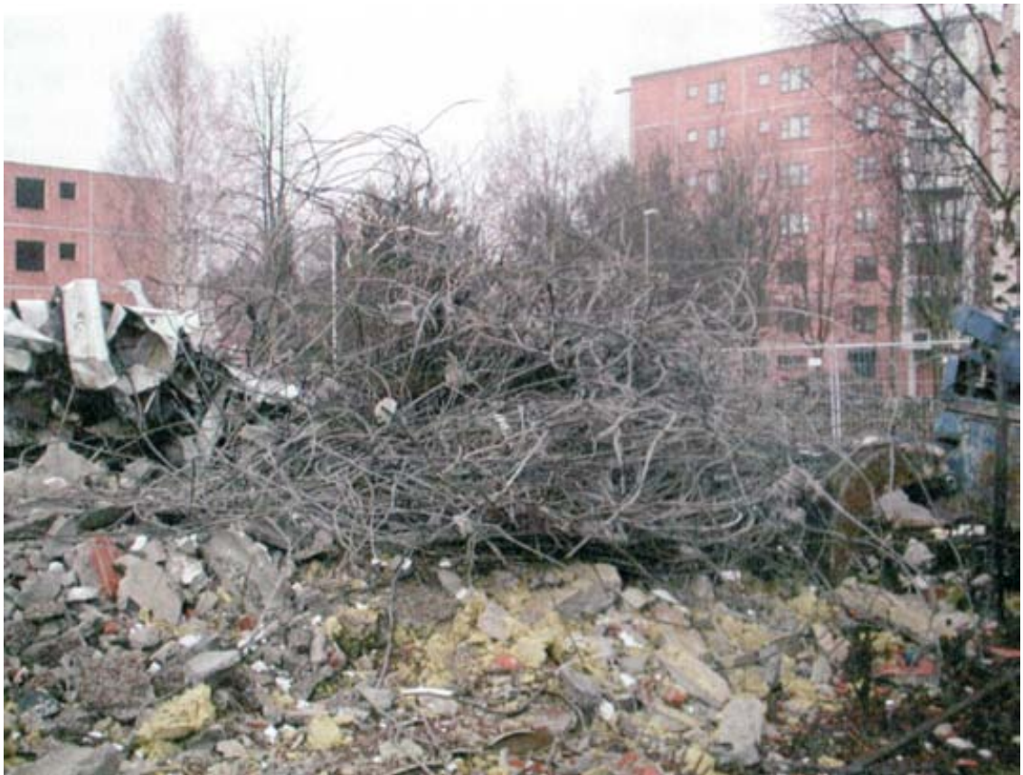
Murskatusta betonista irrotettuja raudoitusteräksiä työmaalla Helsingin Myllypurossa (Kerrostalon purkaminen 2001).
