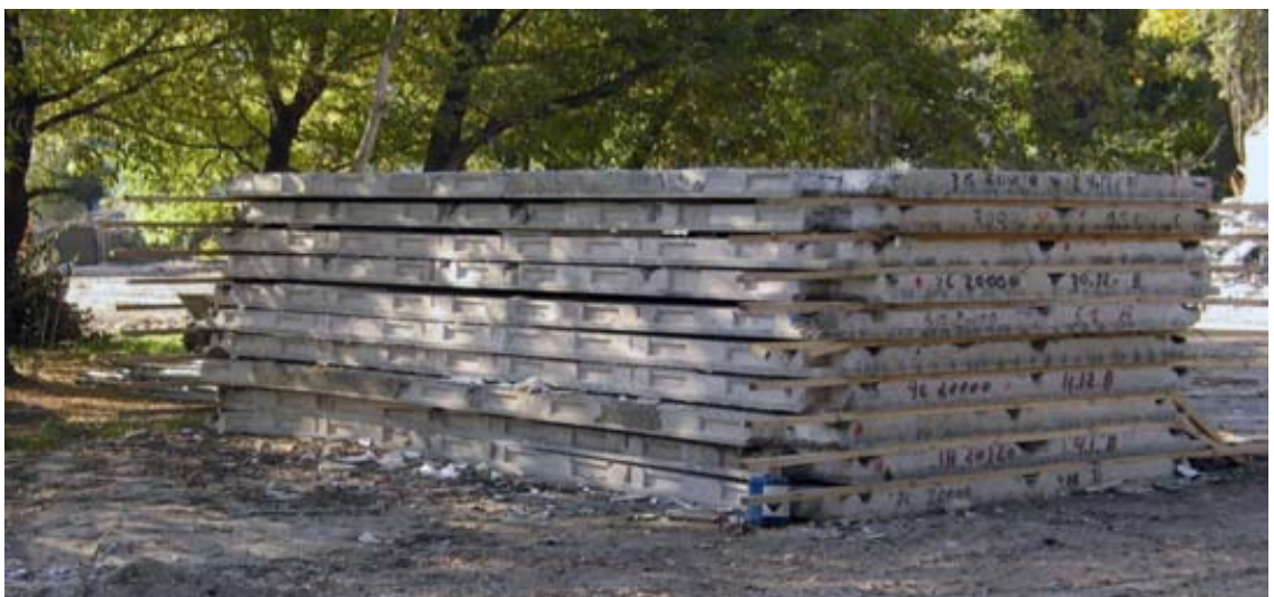
Uudelleenkäyttöön valitut massiiviset välipohjaelementit odottavat purkutontilla kuljetusta uudiskohteeseen. (Asam).
