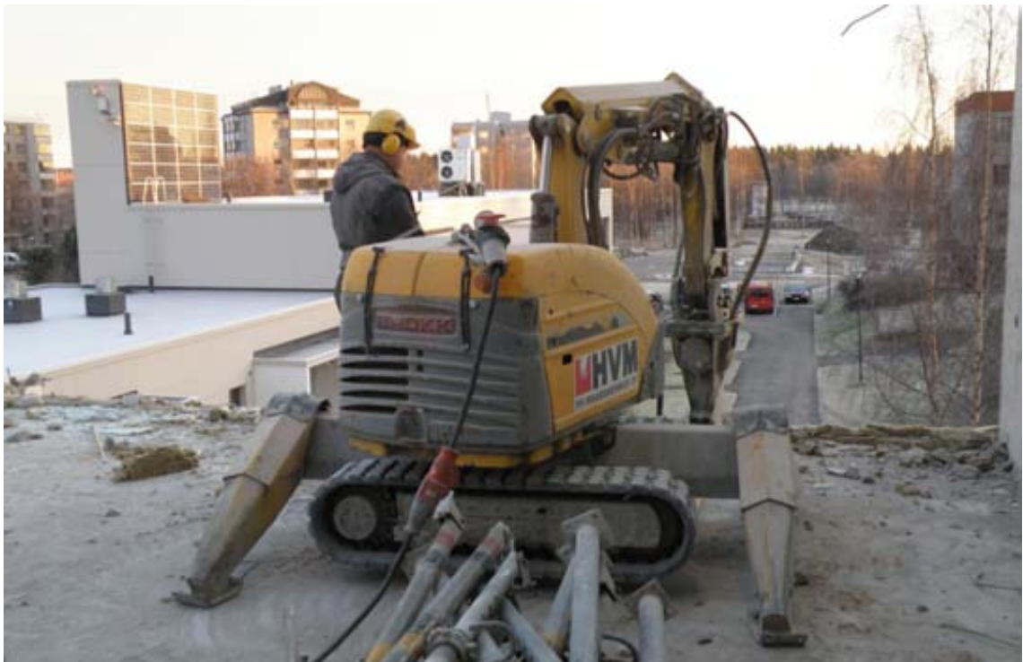
Ontelolaatat irrotettiin rungosta Kummatissa Brokk-piikkausrobotilla.
