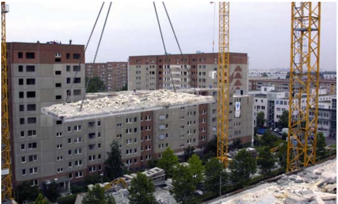
Välipohjaelementtien purkamista ehjänä Berliinissä. Taustalla näkyy tyyppillisiä WBS70-tyypin 11-kerroksisia asuinrakennuksia. (Asam).
