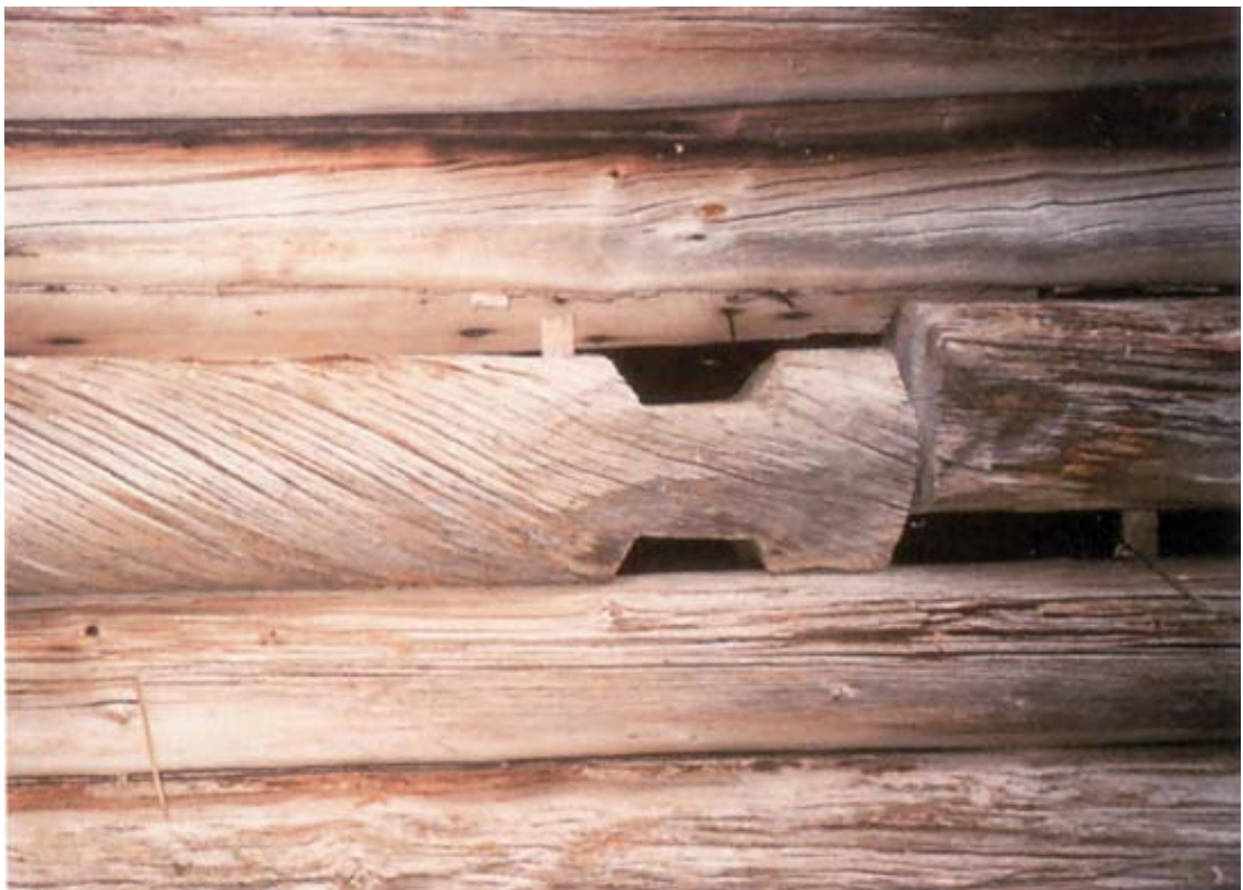
Hirsiä on käytetty uudelleen aina kun on ollut mahdollista. Puretun savutuvan hirsii heinäladon seinässä. (Vuolle-Apiala, 2008)
