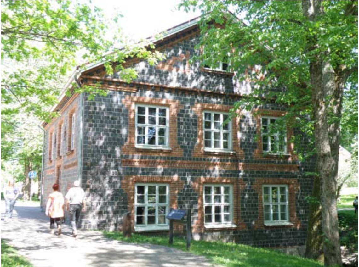
Fiskarsin ruukin mylly vuodelta 1898 on rakennettu hohtavan mustista masuunikuonatiilistä.
