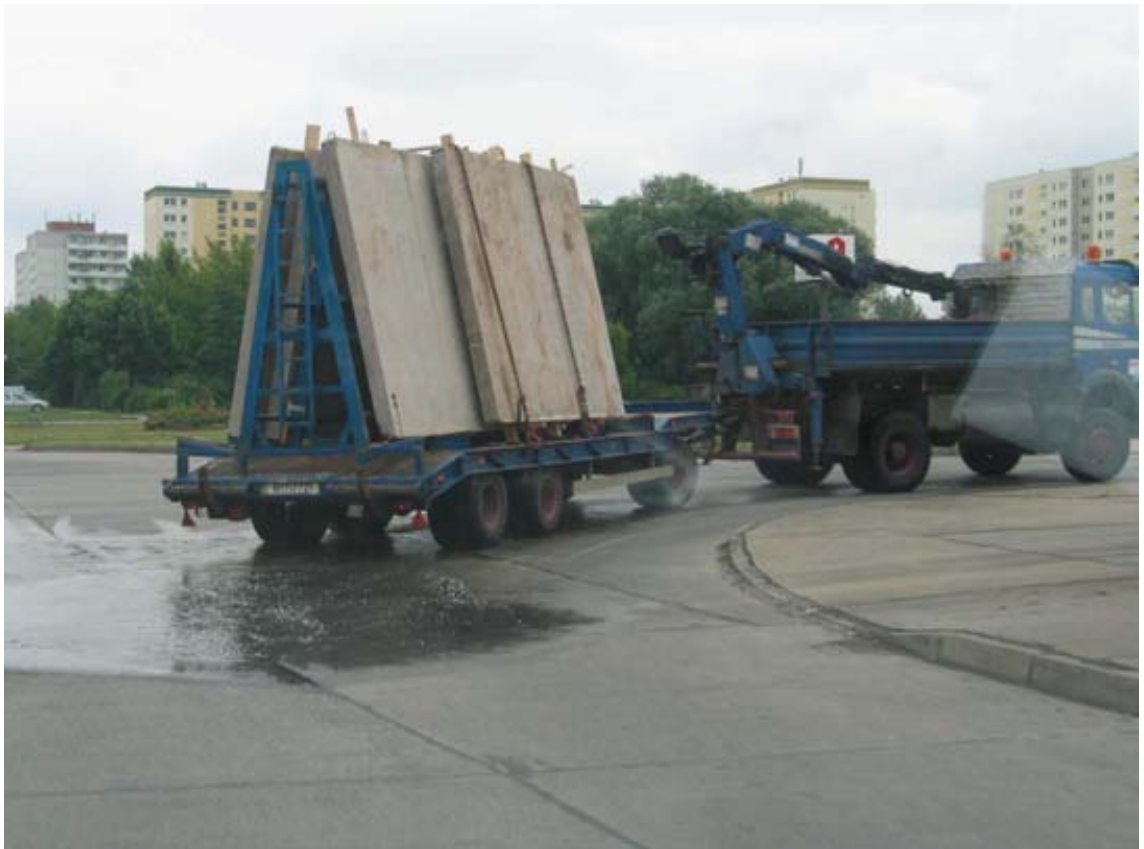
Puretut elementit lähtevät muokattuna Berliinin Marzahn-lähiöstä kohti uutta rakennuspaikkaa esikaupungissa (Asam).
