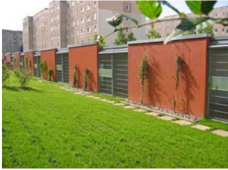
AUTOKATOKSET WALTERSHAUSEN, SAKSA
