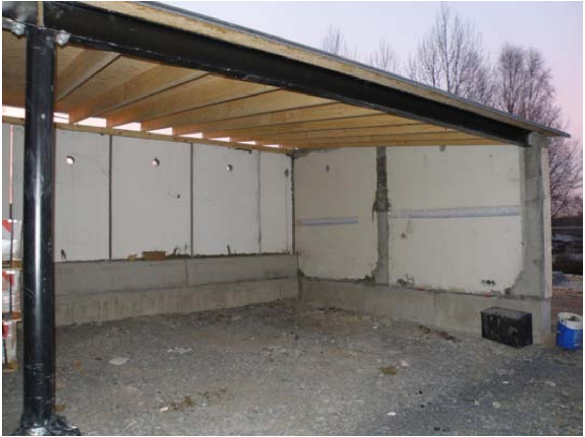
Katoksen takaseinä koostuu parvekepielielementeistä, päädyt umpinaisista kantavista päätyelementeistä.
