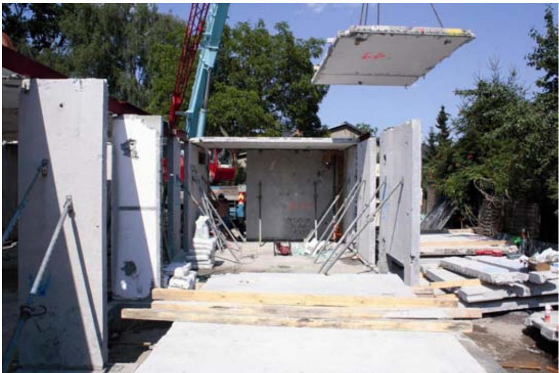
Käytettyjen elementtien asennusta omakotitaloon Karowin kaupunginosassa Berliinissä. (kohde on 7.4). Seinät ovat itse asiassa pystyyn nostettuja välipohjaelementtejä. (Asam).
