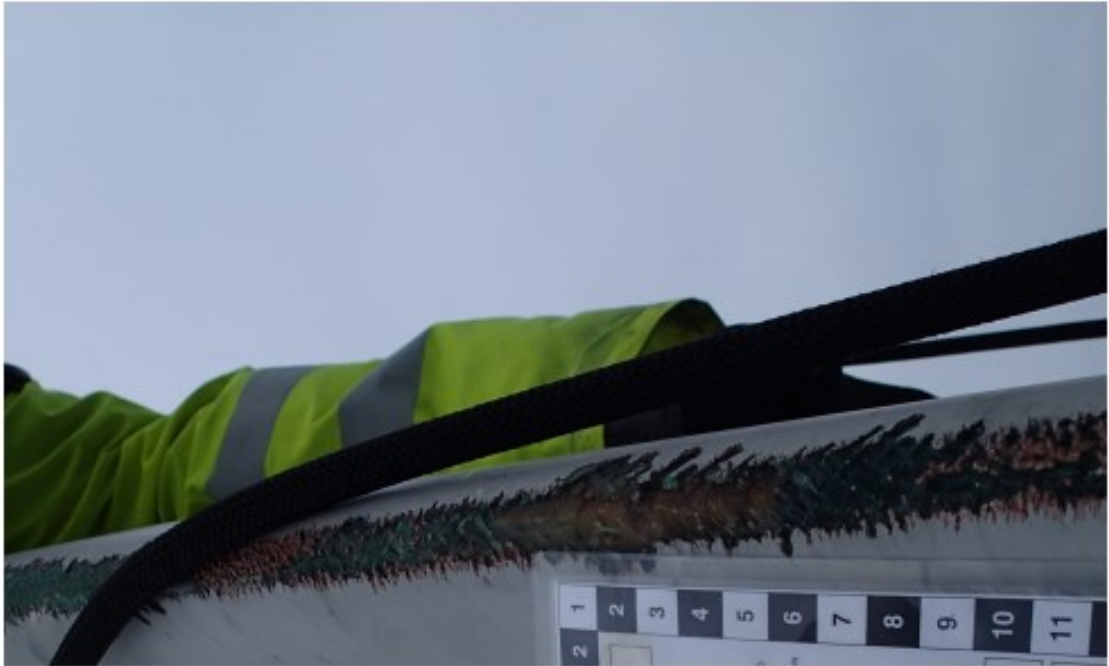
Kuva 8. Lähellä rannikkoa sijaitsevan voimalan lavan etuosa suunnilleen vuoden operatiivisen käytön jälkeen. [18]
