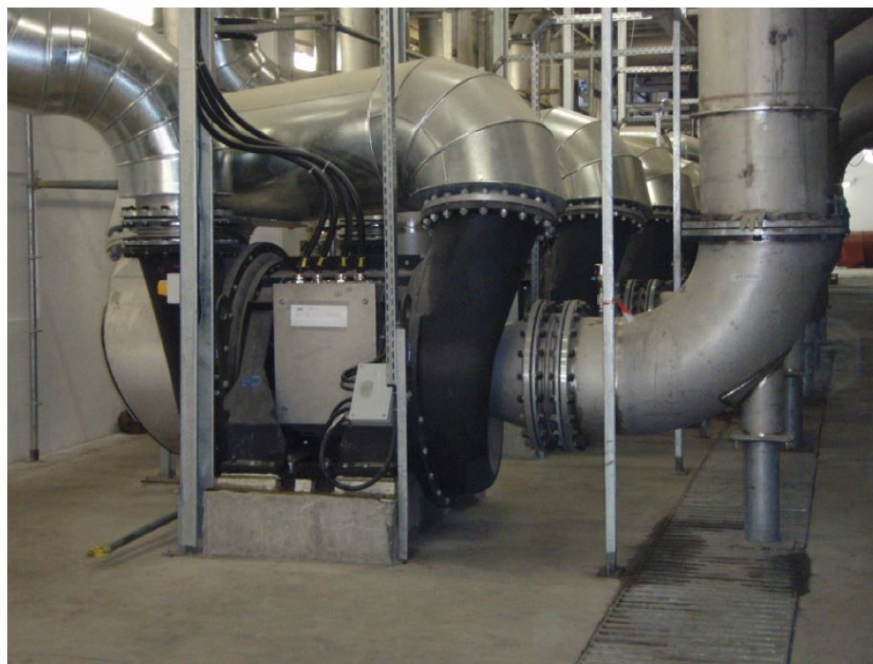
Kuva 8: Kaksivaiheinen kompressorit asennettuna tehtaalla.
