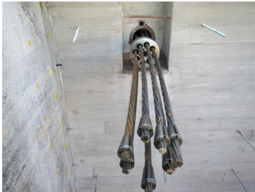
Kuva 2. Lupajan silta, seitsemästä 7-lankaisesta jännepunoksesta koostuva jänne [5]
