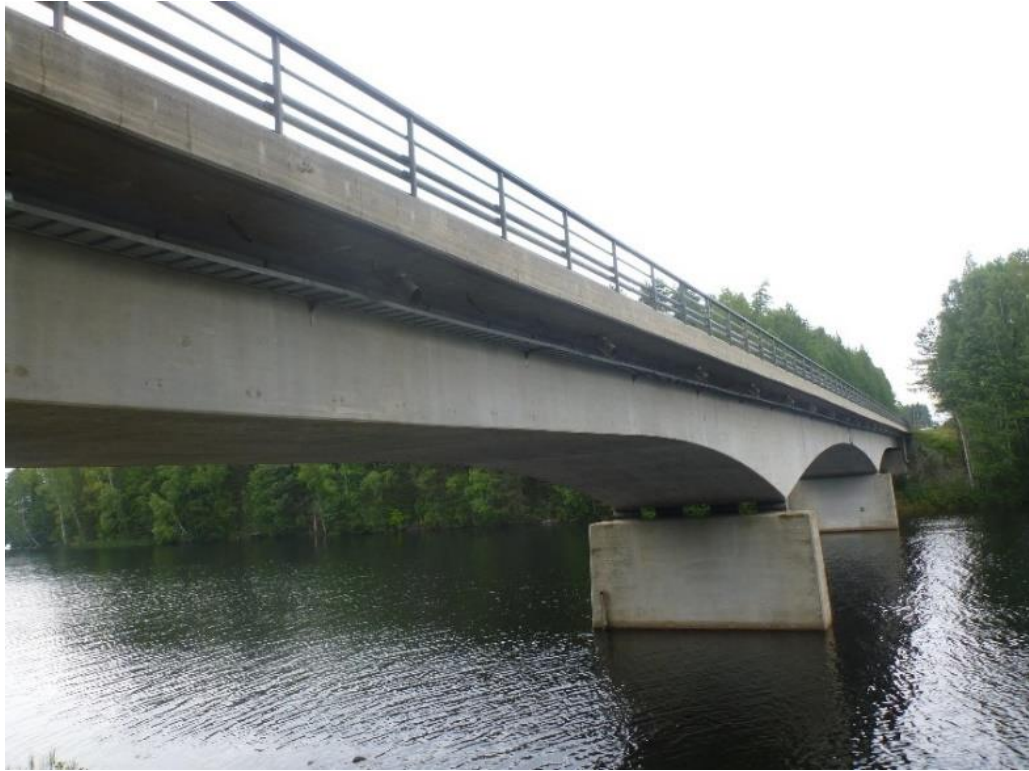
Kuva 19. SK-1001 Syrjäsalmen silta [19]
