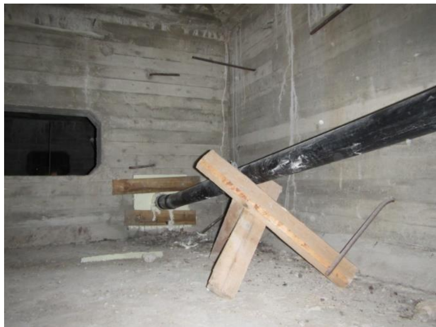
Kuva 12. Väliseinäohjain, Lupajan silta [5]
