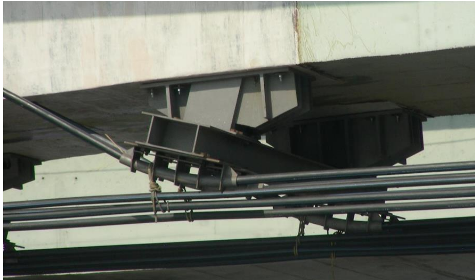
Kuva 13. Terässatulaohjain, Versova bridge [14]
