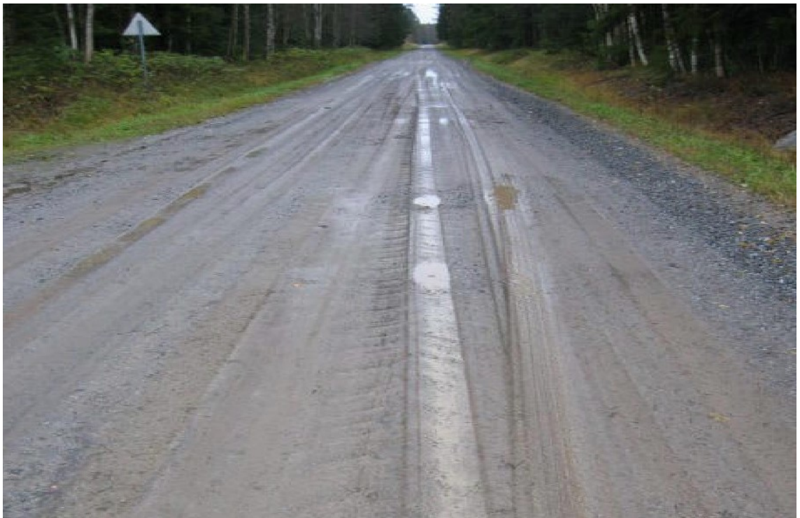
Kuva 14. Lievää pintakelirikkoa maantiellä 17639 (Rantanen et al. 2008).
