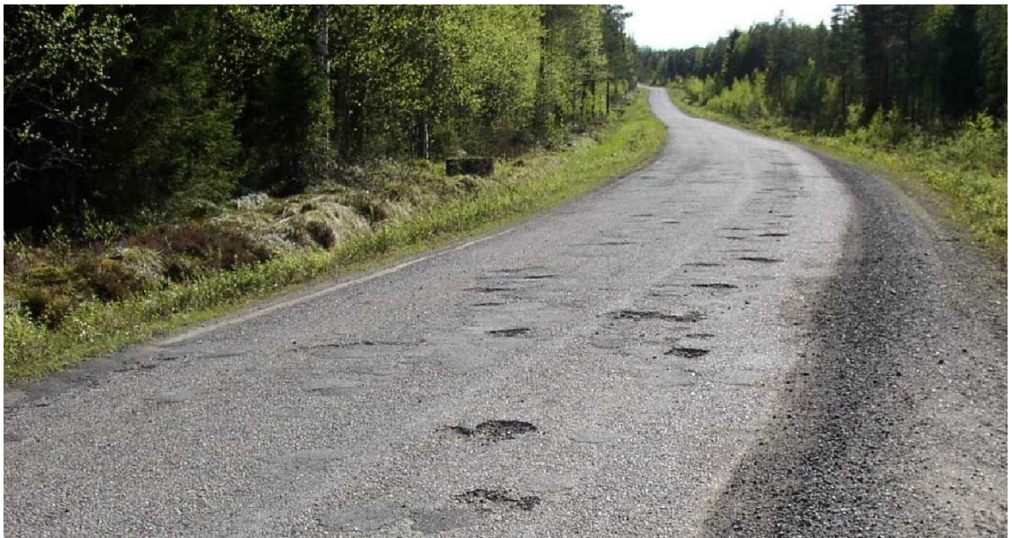
Kuva 8. Kuoppainen SOP-pinta (Lämsä 2005).
