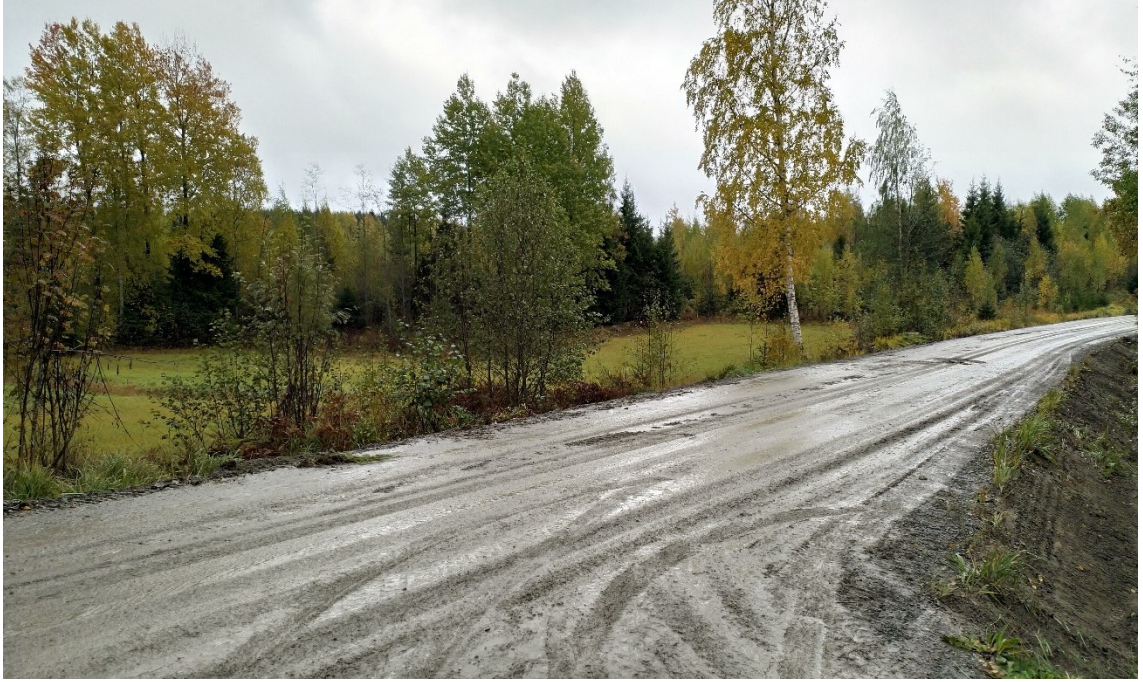
Kuva 27. Alkavaa pintakelirikkoa Härkäläntiellä mt 2991 tierekisteripaalulla 2640.
