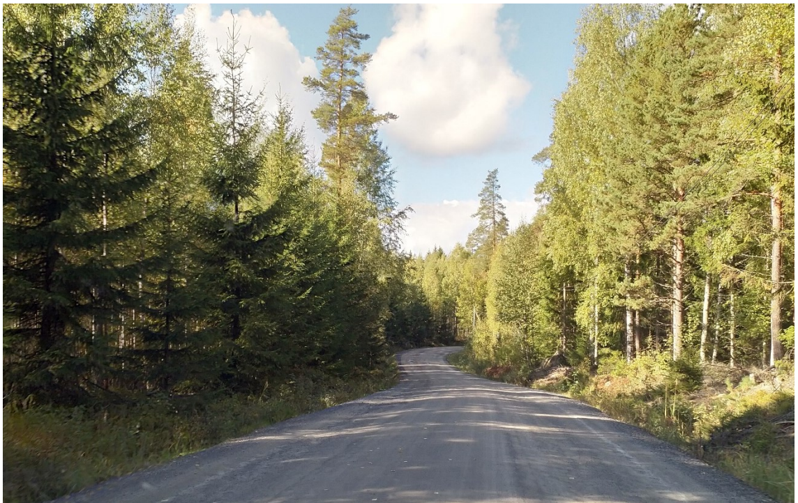
Kuva 25. Hautaantien mt 12995 kunnostettua koeosuutta 2.9.2018.
