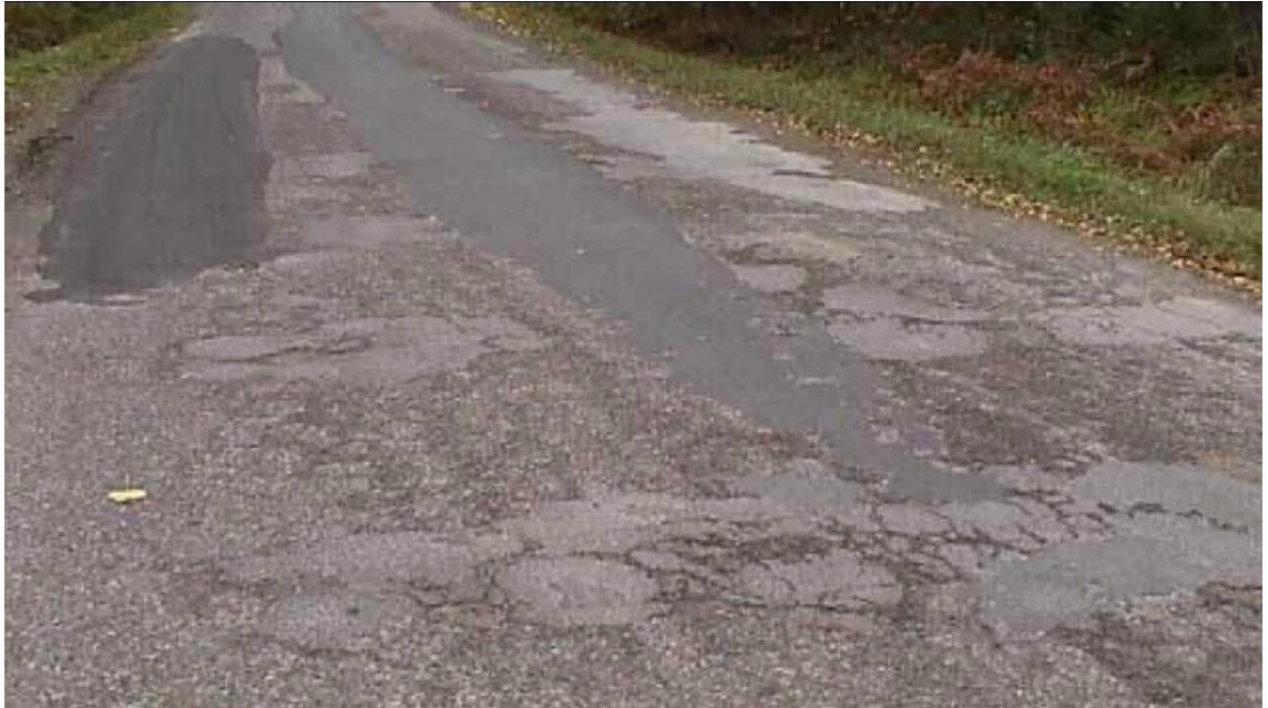
Kuva 9. Huonokuntoinen SOP-pinta (Perälä et al. 2006)
