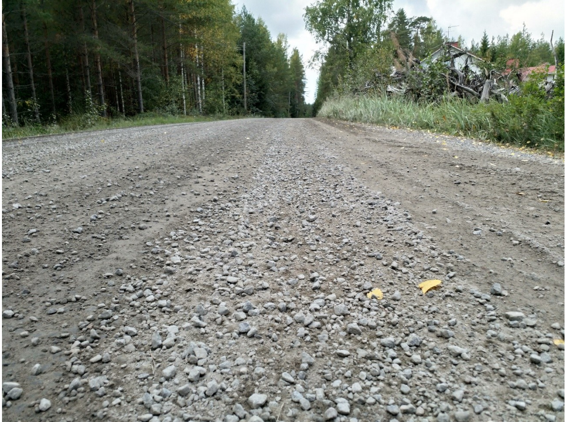
Kuva 26. Alusterällisen kuorma-auton työjälkeä Houhajärventiellä 2.9.2018.
