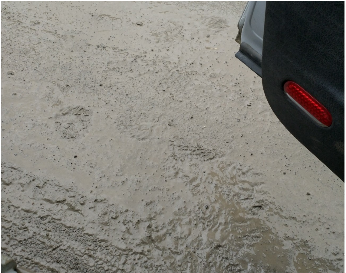
Kuva 28. Liettynyttä kulutuskerrosta Jokivarrentiellä mt 13765 tierekisteripaalulla 1650.
