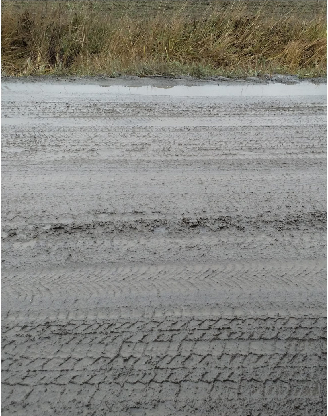
Kuva 31. Pintakelirikkoista kulutuskerrosta Hautaantiellä mt 12995 tierekisteripaalulla 2790.
