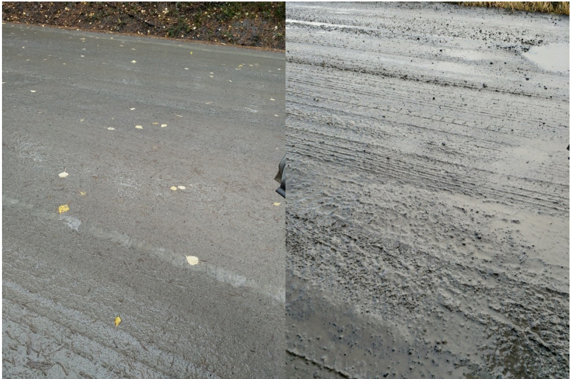
Kuva 29. Vasemmalla kiinteää kulutuskerrosta Hautaantien mt 12995 koeosuudella tierekisteripaalulla 460 ja oikealla liettynyttä kulutuskerrosta Hautaantiellä tierekisteripaalulla 2790
