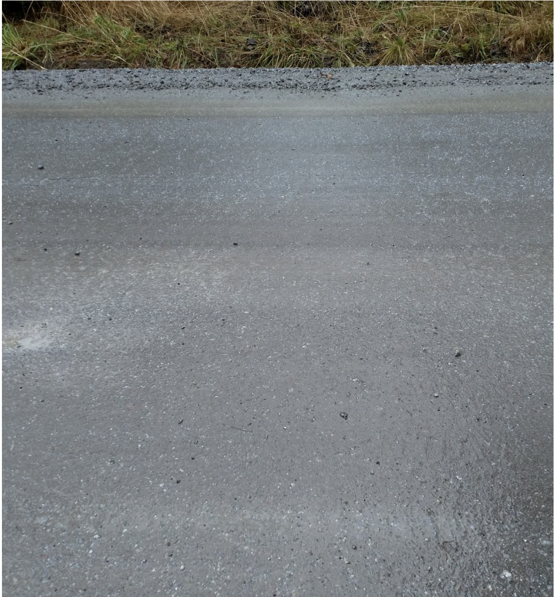
Kuva 30. Uusi kulutuskerros Jokivarrentiellä mt 13765 tierekisteripaalulla 430.
