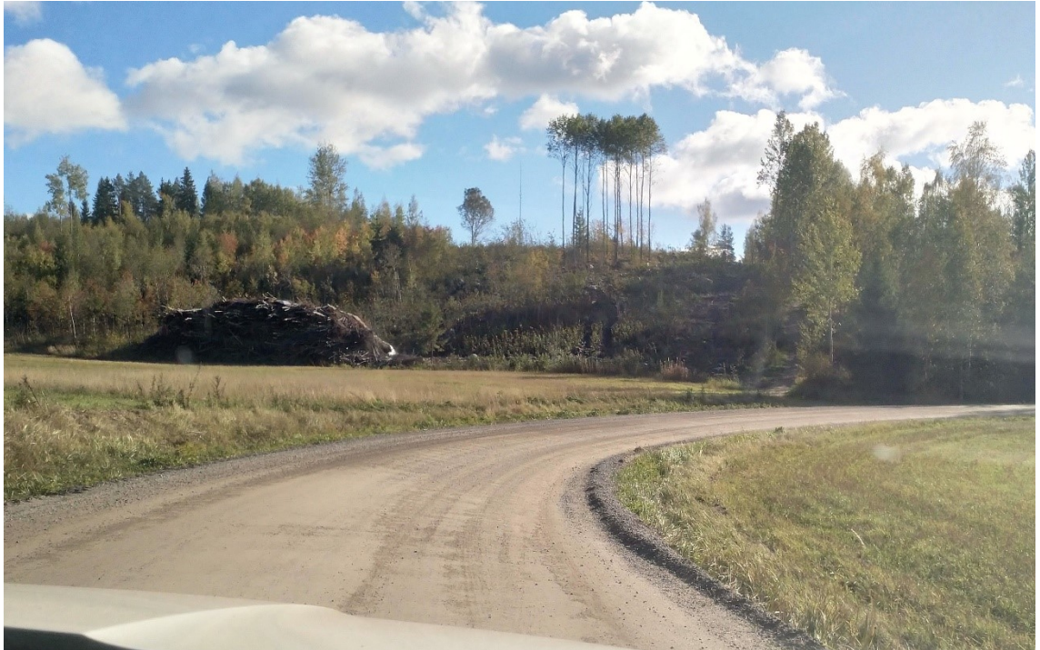
Kuva 23. Hoidon synnyttämää reunapalletta Kellosalmentiellä mt 14213 tierekisteripaalulla 2110.
