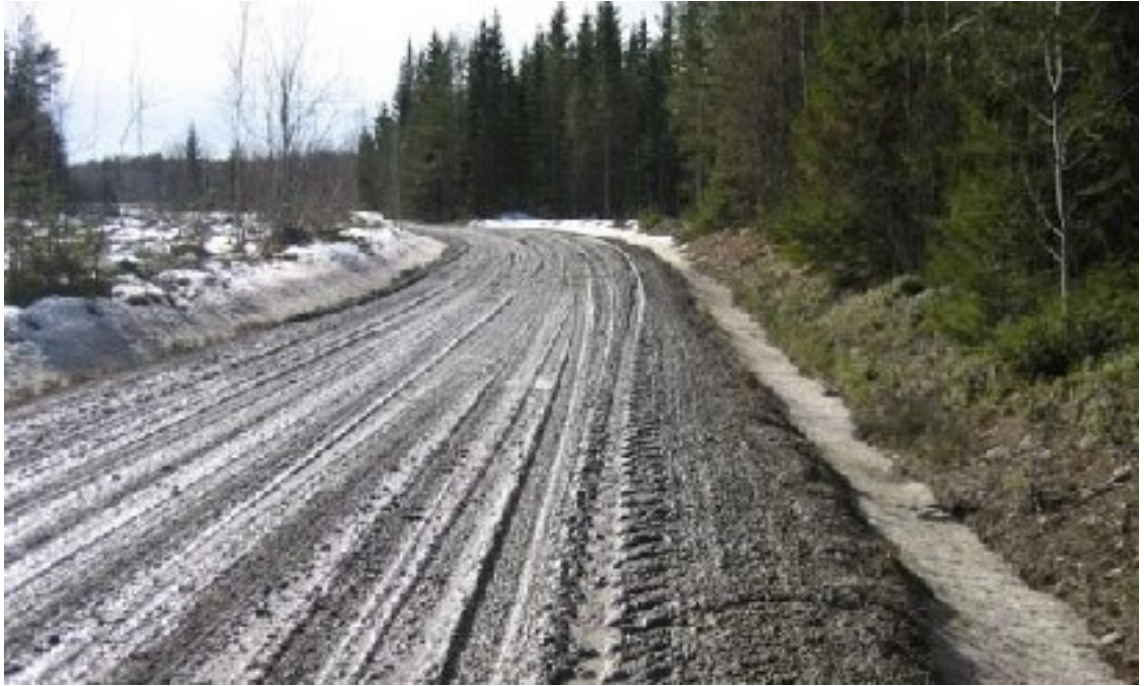
Kuva 13. Pintakelirikkoa maantiellä 17353 (Rantanen et al. 2008).
