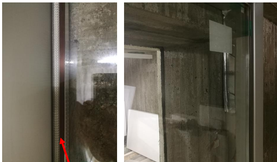
Kuva 6.4: Metallinen eristesukka lasin reunassa yksittäisen eristyslasipaketin mittauksessa (vas.). Kolminkertainen lasirakenne paikallaan (oik.).
