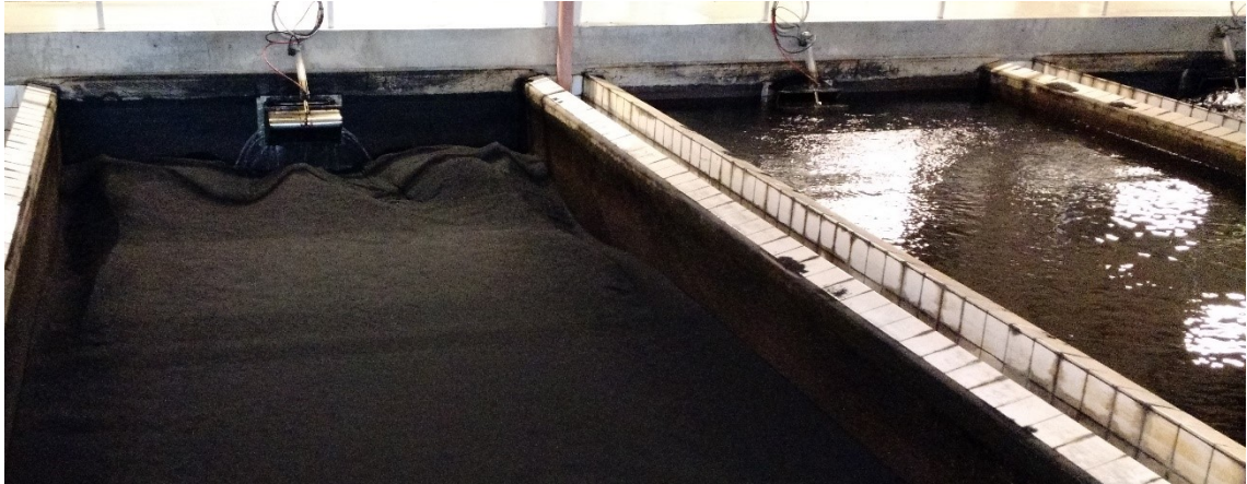
Kuva 4.2. Ruskon pintavesilaitoksen aktiivihiilisuodattimia. Vesi on laskettu näytteenottoa varten etualalla olevasta suodattimesta.
