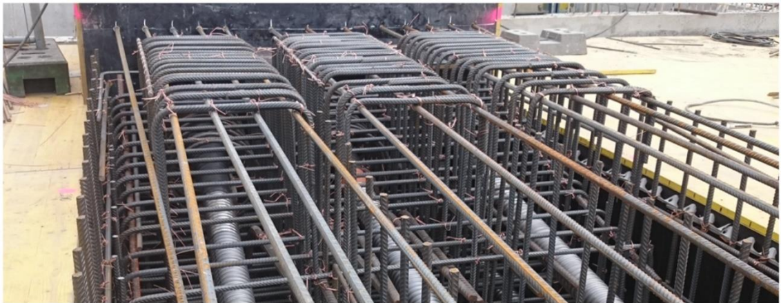
Kuva 25 Ankkurointialueen betoniraudoituksen asennus palkin päässä
