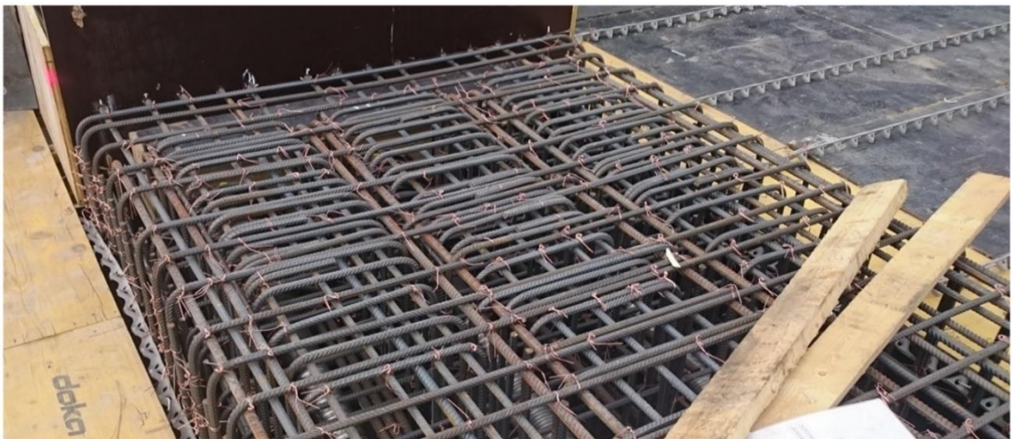
Kuva 26 Palkin pään betoniraudoitus asennettuna
