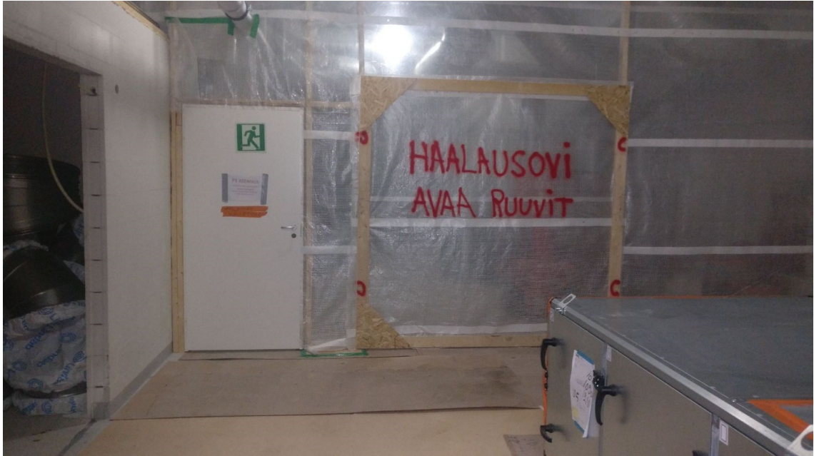
Kuva 4. P1-osastointiin tehty seinä. Tiedottamisella on tärkeä tehtävä.
