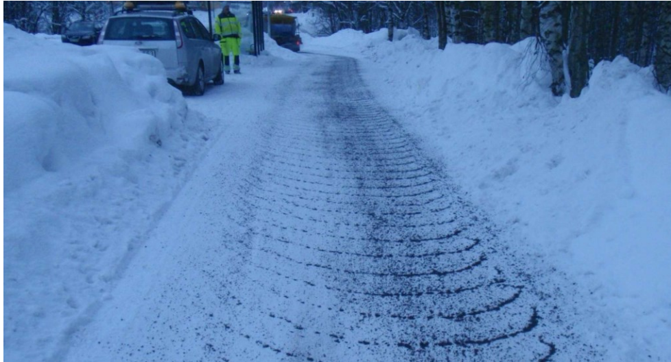
Kuva 46 Warm wetted sand -menetelmässä hiekka kostutetaan lämpimällä vedellä ennen sen levittämistä. (Kuvan lähde: Niska 2013)
