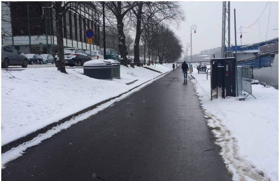
Kuva 49 Harjasuolatun yhdistetyn jalankulku- ja pyöräväylän pinta on puhdas lumesta eikä polannetta pääse kertymään. (Kuva: Anette Korkiakangas)
