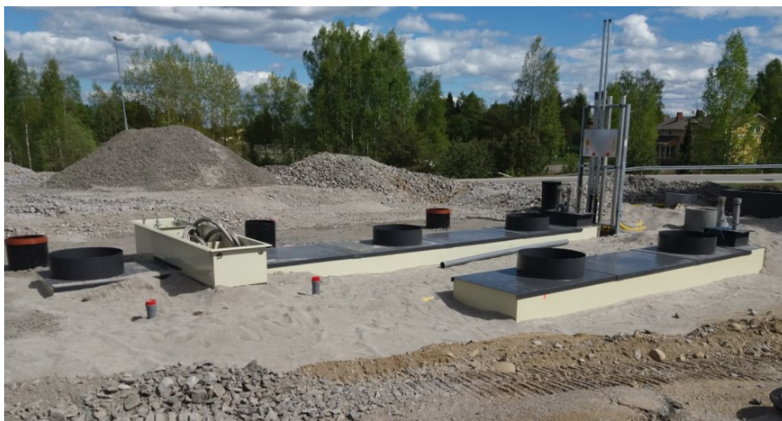
Kuva 11. Suojakerroksen rakentaminen hiekasta ©Saranen
