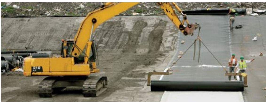
Kuva 14. HDPE-kalvon levitystä (Stallion Coatings & Construction Company 2017)
