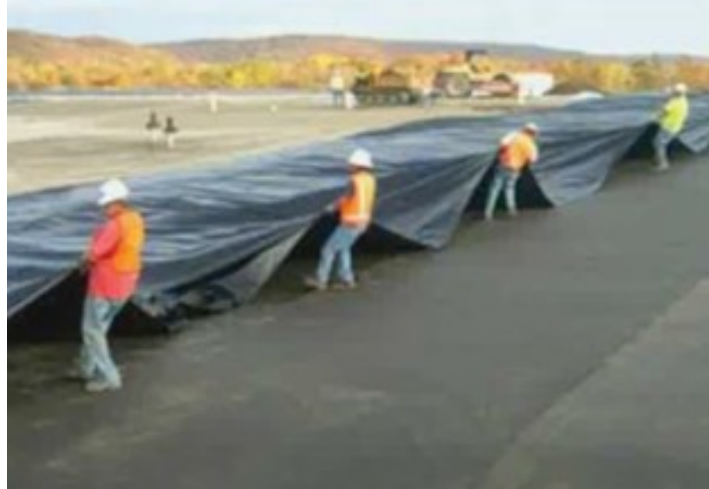
Kuva 24. EIA-kalvon asennusta (Leppänen 2015)
