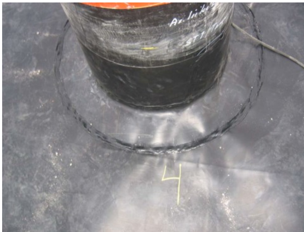
Kuva 17. Pursotehitsuksella tehty sauma (Ölly- ja biopolttoaineala ry 2016, s.30)
