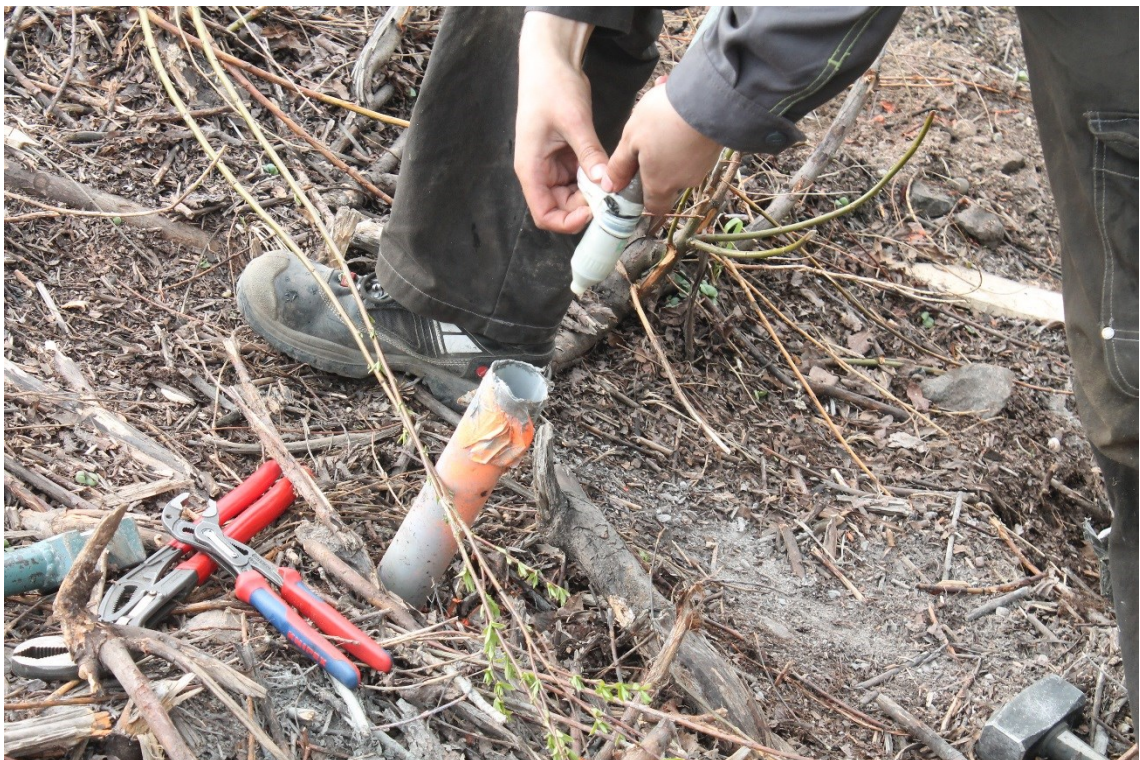
Kuva 6.5. Huokosvedenpaineanturin asennus kohteessa km 238+280.
