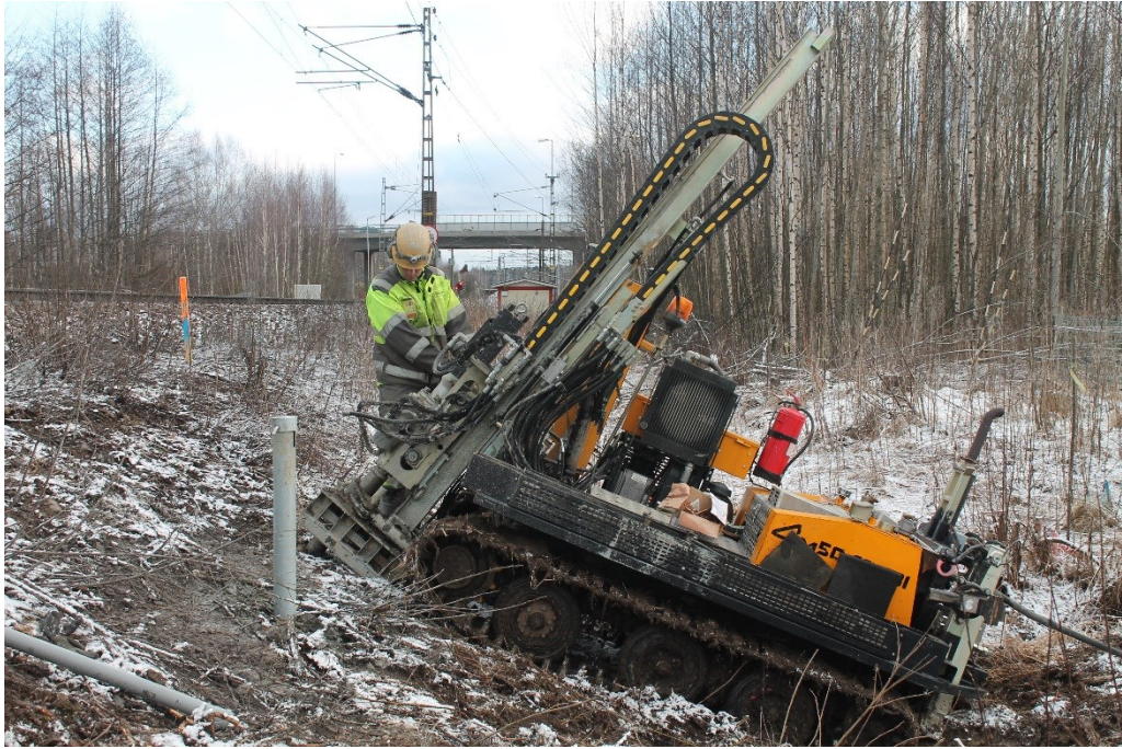
Kuva 6.1. Huokosvedenpaineantureiden suojaputkien asennus VR:n kairavaunulla kohteessa km 233+900.
