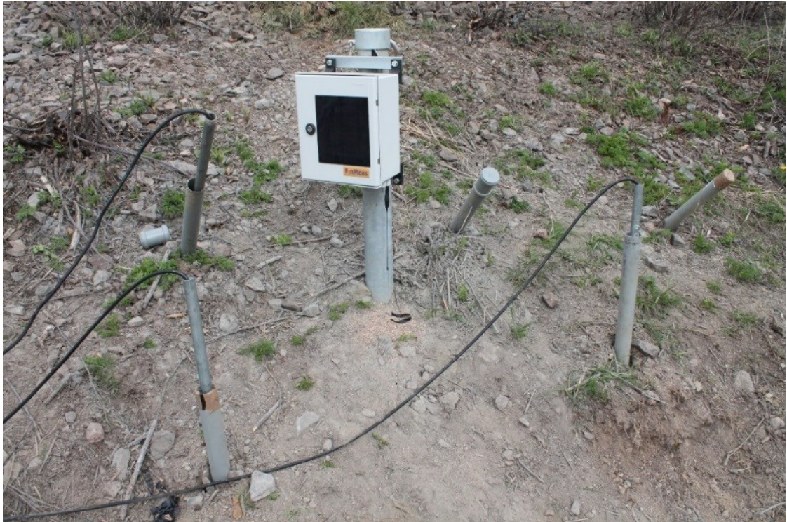
Kuva 6.4. FinMeas Oy:n asentama inklinometri sekä kolme asennettua huokospaineanturia kohteessa km 233+900.
