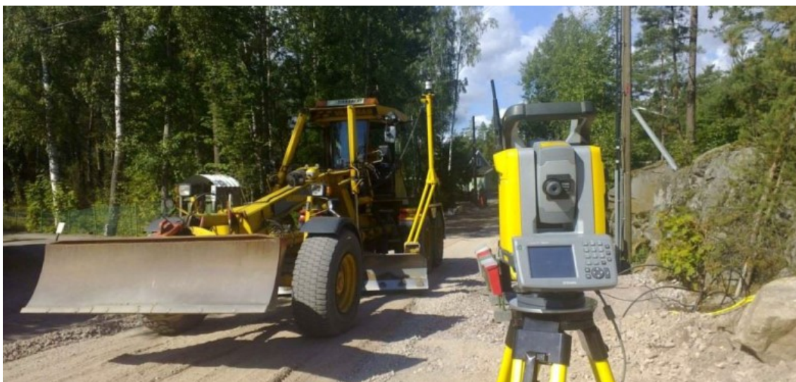
Kuva 13. Takymetripaikannusta hyödyntävä tiehöylä. [35]
