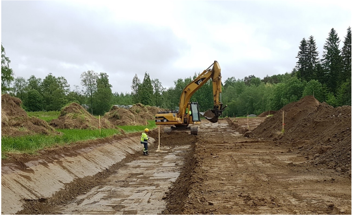
Kuva 21. Uuden tien leikkauspohjan kaivuu. [61]
