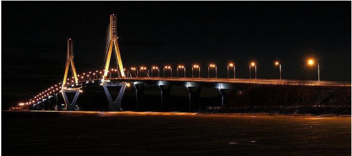
Kuva 5. Vaasan Raippaluodon sillan valaistus [5].
