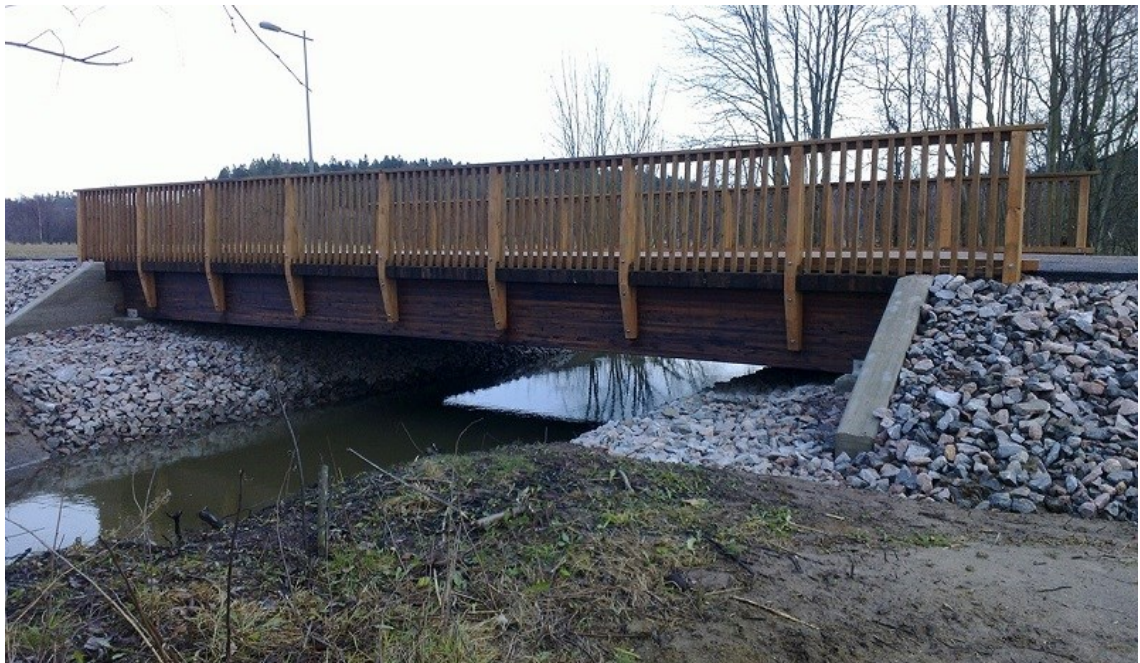
Kuva 6. Espoon Fallanginsilta on yksiaukkoinen palkkisilta, jonka kantavana rakenteena ovat pituussuuntaiset liimapuupalkit [15].
