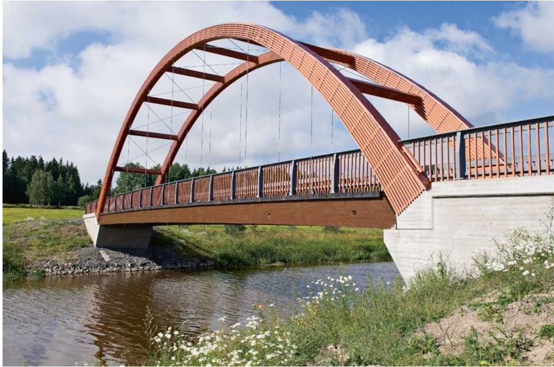
Kuva 9. Ypäjän Kurjenmäen silta on yksiaukkoinen kaarisilta [15].
