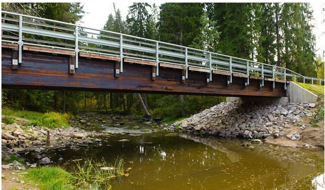
Kuva 13. Hyvinkäällä sijaitseva Otavantien yksiaukkoinen poikittaisjännitetty silta [15].
