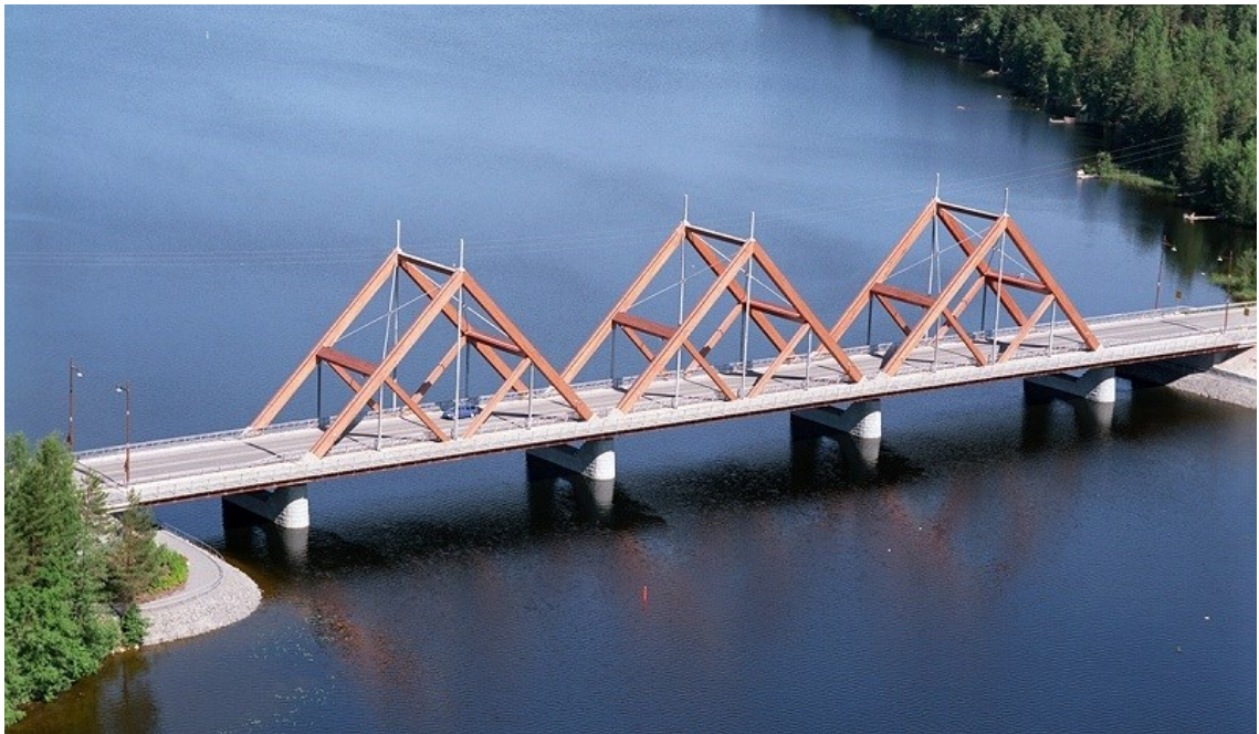
Kuva 12. Mäntyharjulla sijaitseva Vihantasalmen viisiaukkoinen liimapuinen riippuanssilta, jonka kansi on teräsbetoninen [15].
