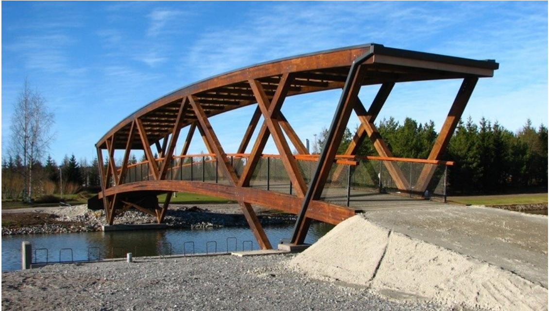
Kuva 14. Paraisten yksiaukkoinen katettu raittisilta, jonka edusta on vielä viimeistelemättä [14].
