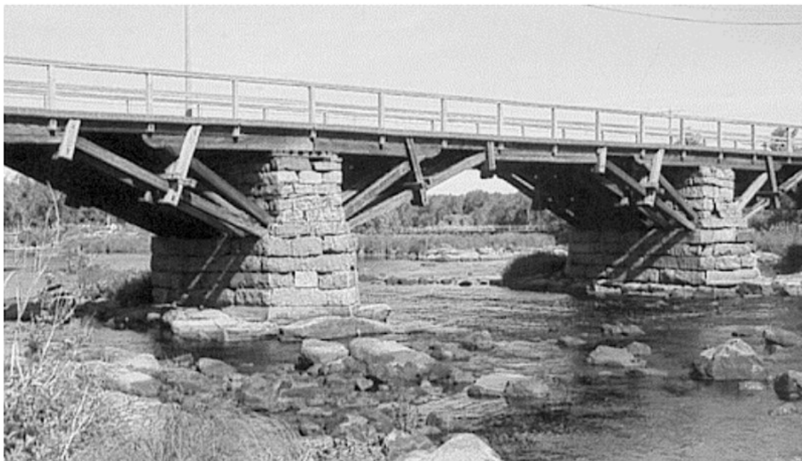
Kuva 15. Pyhäjoella sijaitseva 4-aukkoinen tukiansassilta [2, s. 8].
