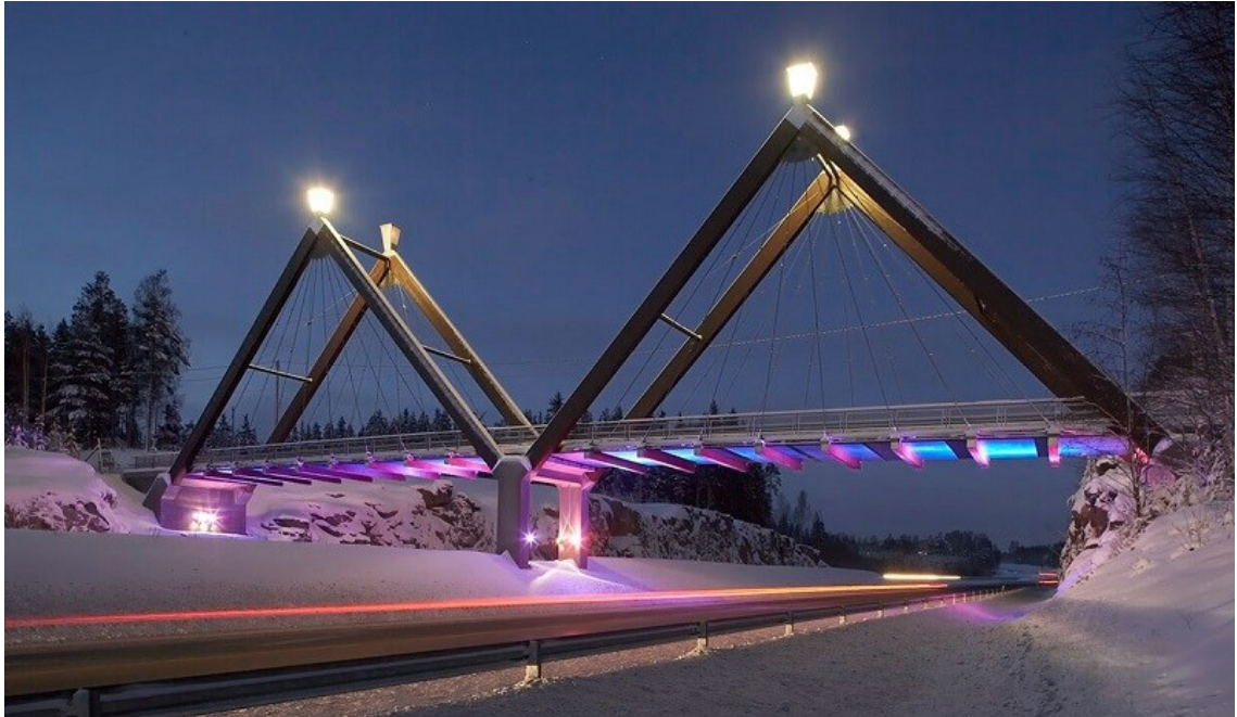
Kuva 8. Haikulan silta on kaksiaukkoinen riippuanssilta [15].
