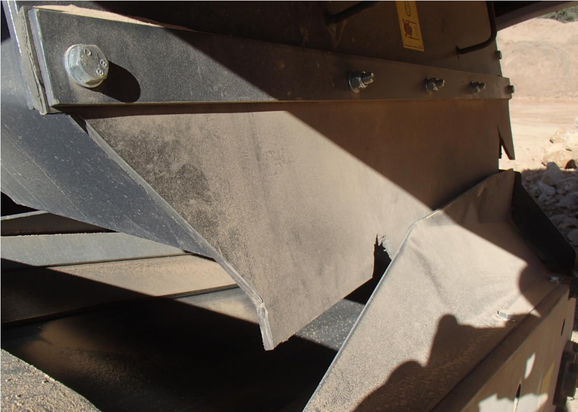
Kuva 42. Puutteellisesta suunnittelusta johtuva vaurio
