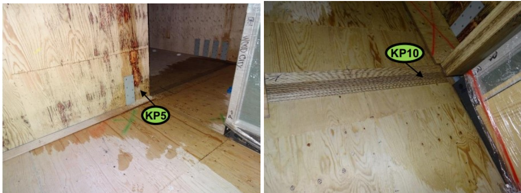
Kuva 4.15. Näytepalamittauksia 3. kerroksen väliseinästä (vas.) ja välipohjaelementin päätypalkista 5. kerroksessa päätyasunnon kynnyksen kohdalta. (Sweco Asiantuntijapalvelut Oy, 15.3.2017)
