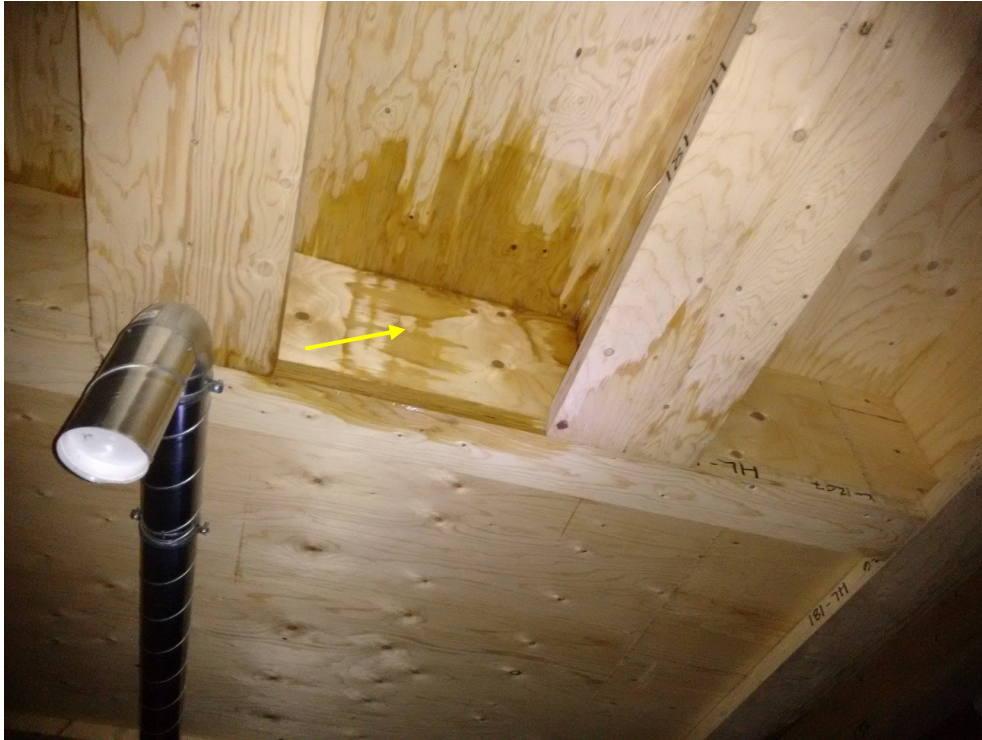
Kuva 15. Kylpyhuonesyvennys välipohjassa sekä mittauspisteen 35 sijainti (kesk. ripaväli) (13.3.2017).
