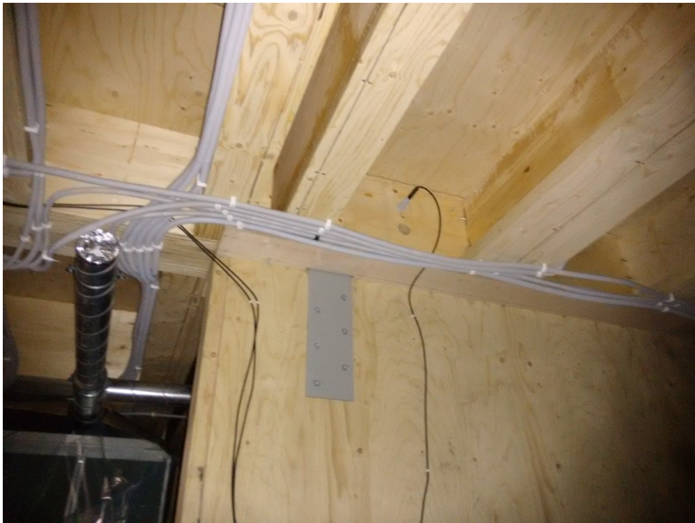
Kuva 26. Ripalaatat väliseinän kohdalla ja mittauspisteen 23 sijainti, jonka alta otettu näytepala (26.4.2017).
