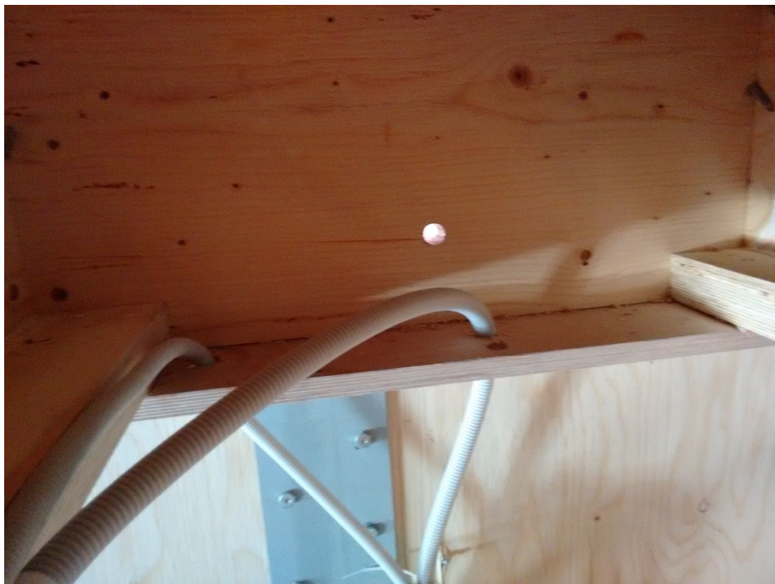
Kuva 33. Julkisivun alle jäävää mittausta varten toteutettu porareikä päädyn ulkoseinän läpi välipohjan kohdalla (12.4.2017).
