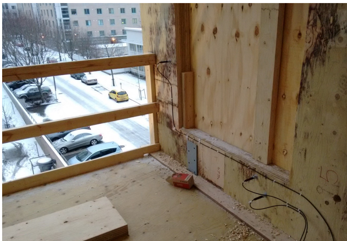
Kuva 5. Rakennuksen päätyseinän nurkka ja mittauspisteiden 7 (vas.), 8 (kesk.) ja 9 (oik.) sijainti (2.2.2017).
