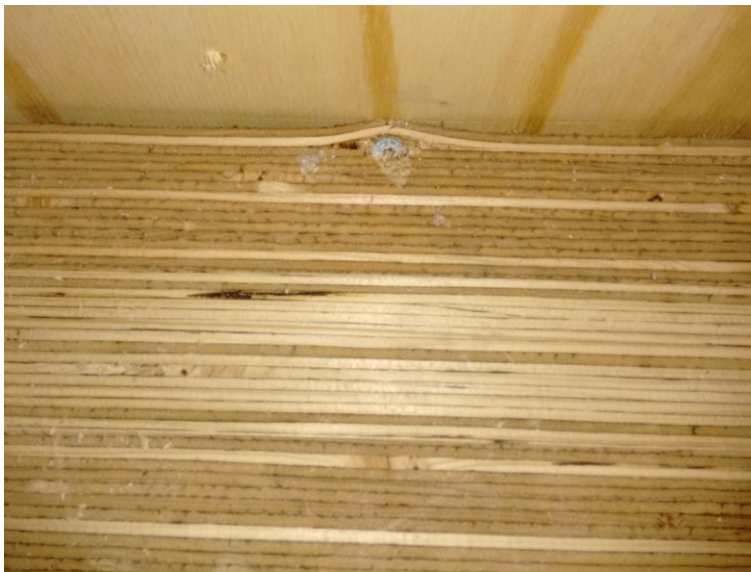
Kuva 2.6. Ulkoseinälevyissä ikkuna-aukon alareunassa erottuvat pystysuuntaiset viilut tummempina. (27.4.2017)
