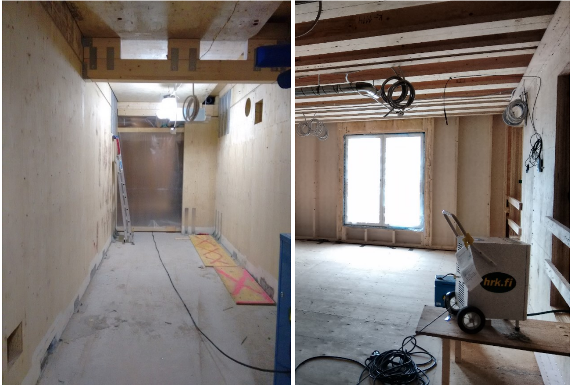
Kuva 3.19. Lämmityksen tehostaminen erottamalla päätyhuoneistot ripustetulla muovilla porraskäytävästä 2. kerroksessa (vas.) ja lisäämällä lämmitystä päätyhuoneistoissa (oik.) (27.4.).
