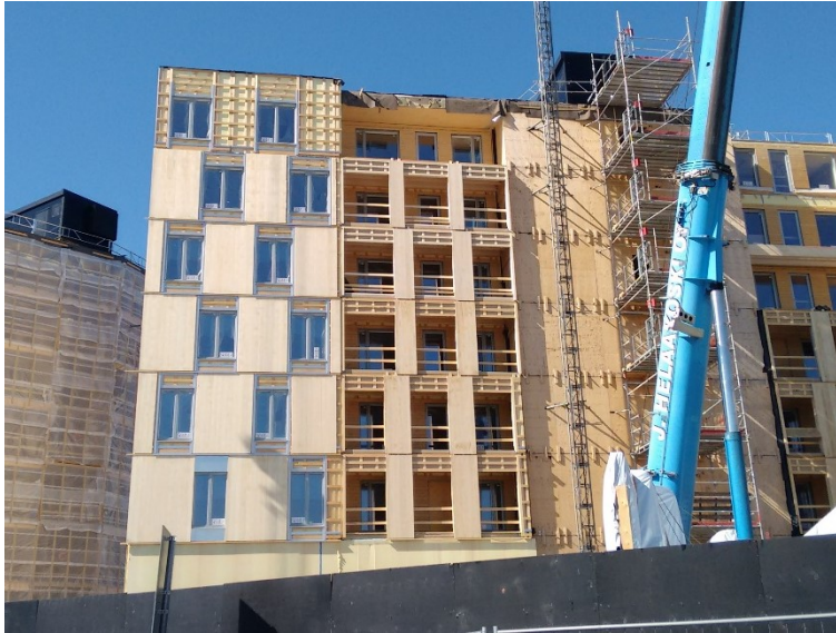
Kuva 1.1. Julkisivuasennusta ensimmäiseen asuintaloon eli B-taloon itäpuolelta. (15.6.2017)
