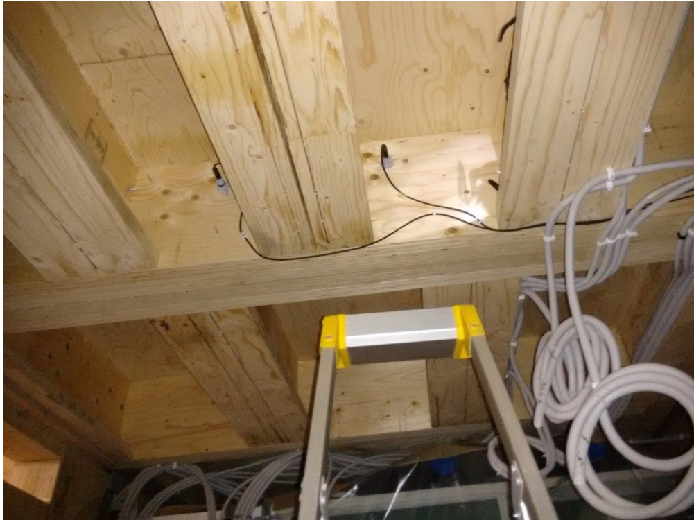
Kuva 25. Ripalaattojen päätypalkit aukon kohdalla sekä mittauspisteiden 21 (vas.) ja 22 (oik.) sijainti (6.3.2017).
