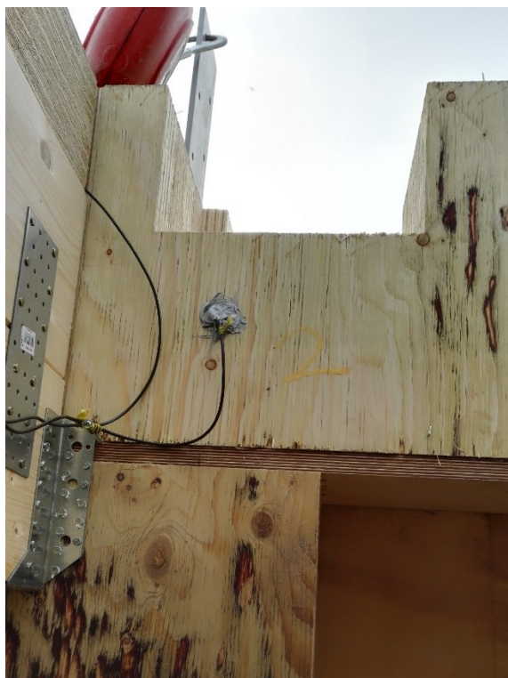
Kuva 6 Anturin asennuspaikan sijainti viemäri­läpiviennin alapuolella (RF SensIT Oy)
