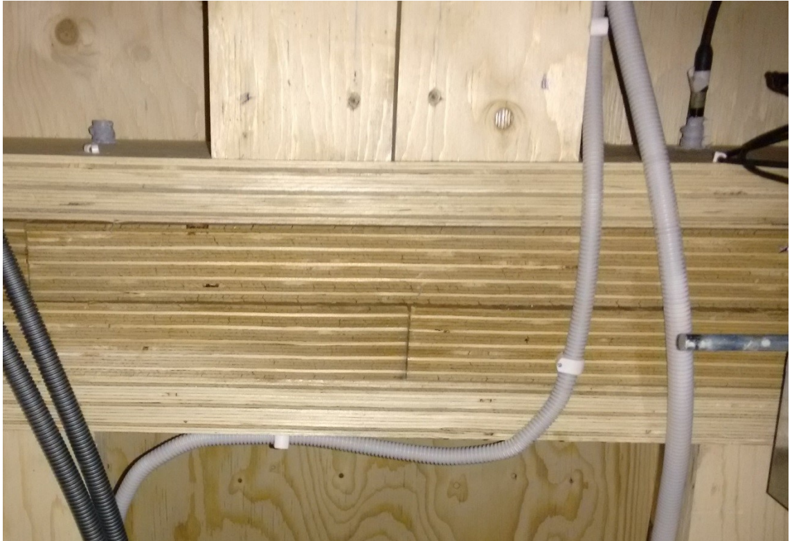
Kuva 3.6. Välipohjajaelementtien päätypalkit alhaaltapäin kuvattuna toisen kerroksen mitauspisteen kohdalla (12.5.2017).
