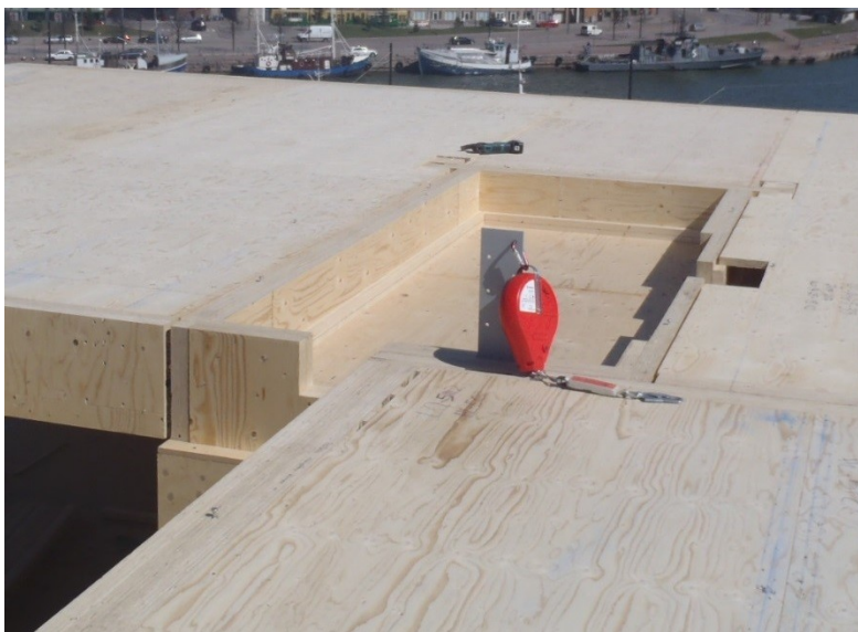
Kuva 3.7. Kylpyhuonesyvennys välipohjassa asennusvaiheessa A-talossa.
