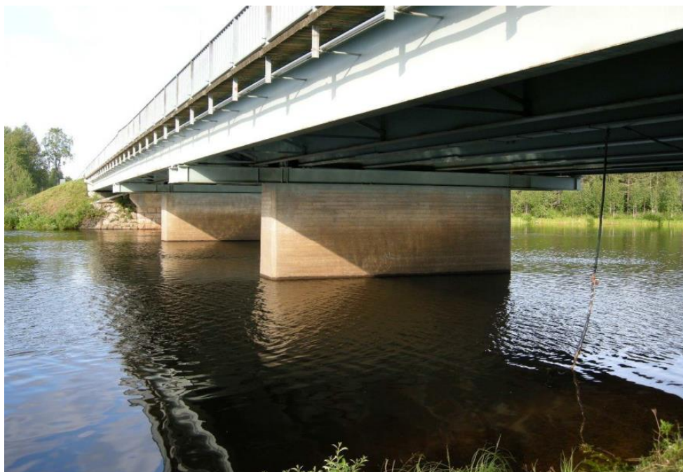
Kuva 8.1 Jeesiöjoen silta vuonna 2010 ennen vahventamista [1]
