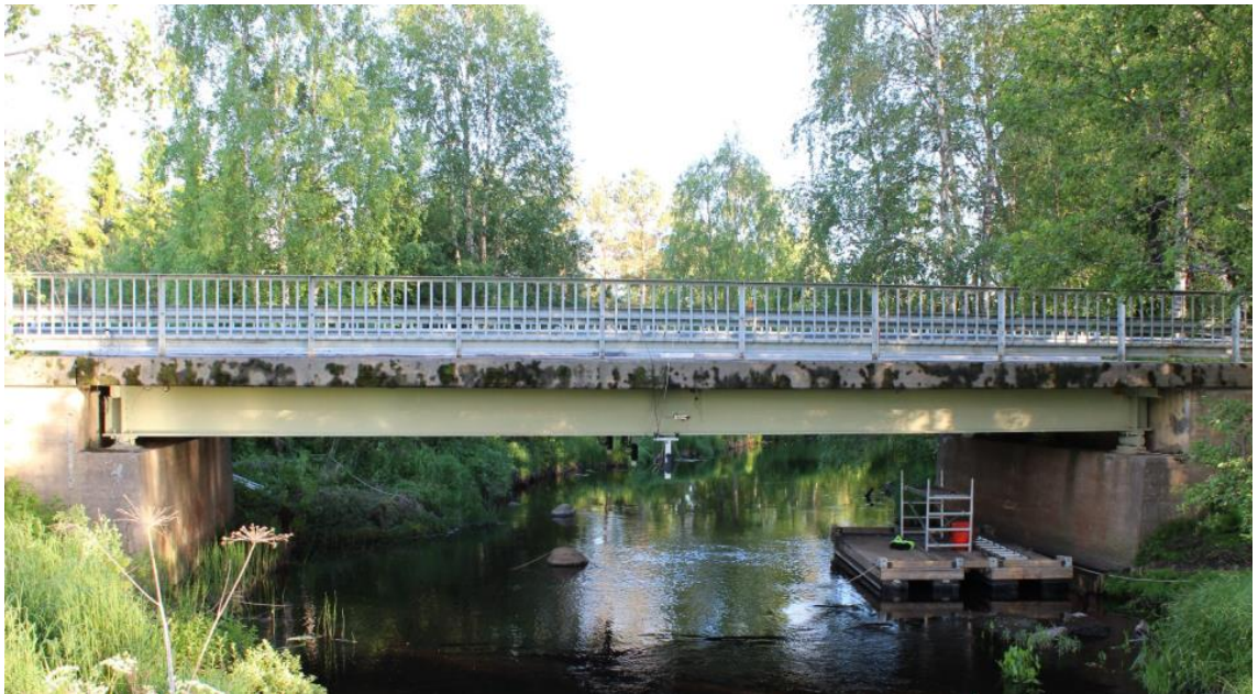
Kuva 4.2 Ronnalansilta koekuormituksessa kesällä 2017
