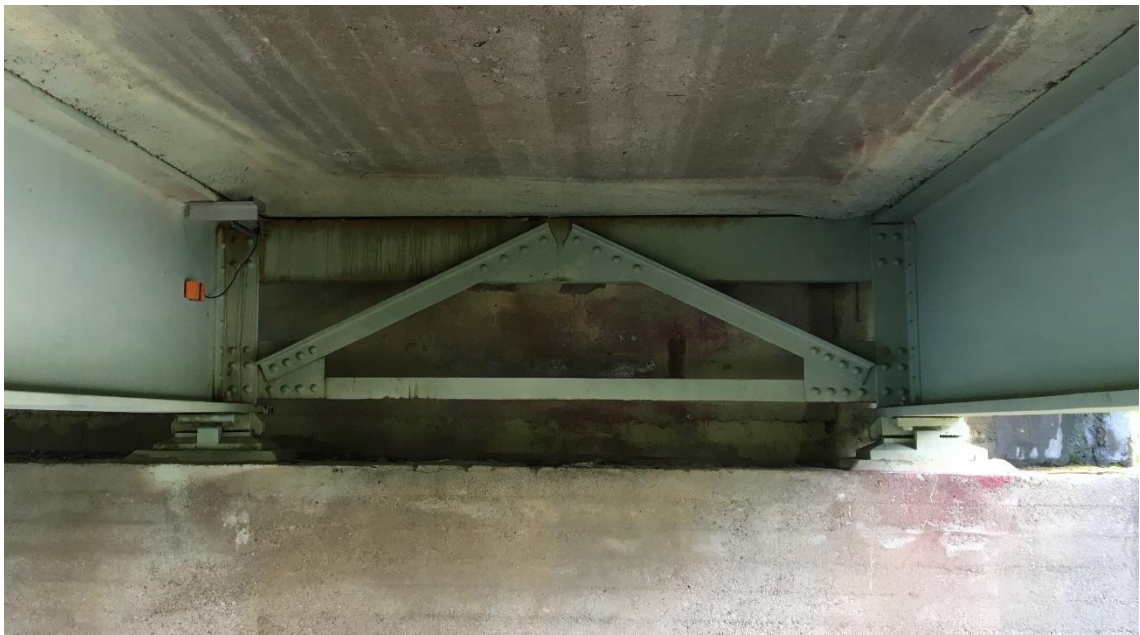
Kuva 4.10 Ronnalan sillan päätyristikko
