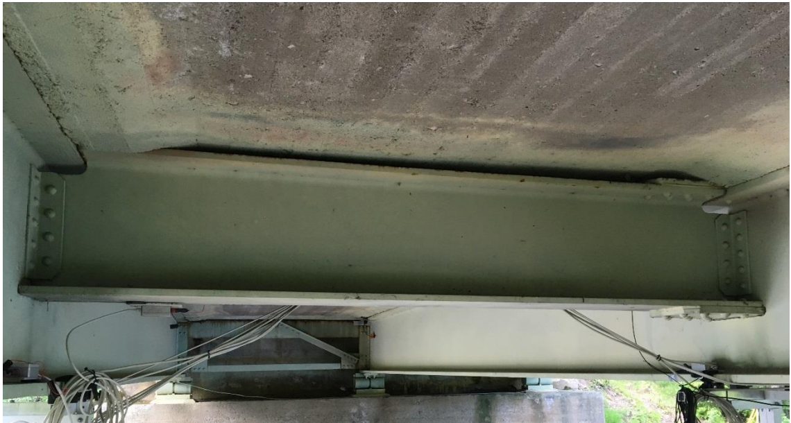
Kuva 4.6 Ronnalan sillan poikkipalkki aukon keskellä
