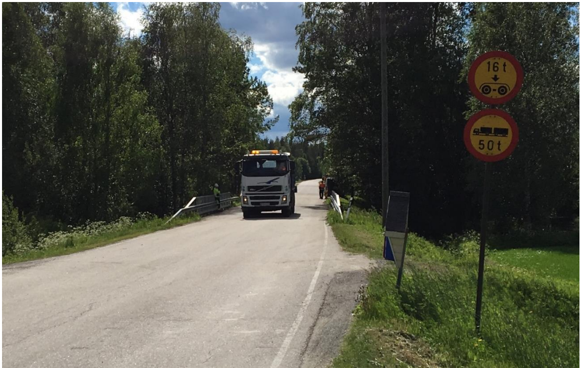
Kuva 4.1 Ronnalansillan yleiskuva koekuormituksessa 2017
