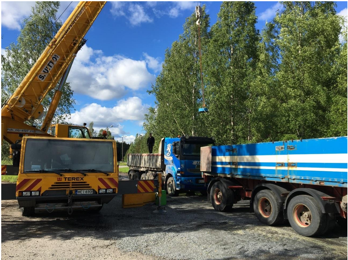
Kuva 4.21 Koekuormitusajoneuvojen lisäpainojen asennus
