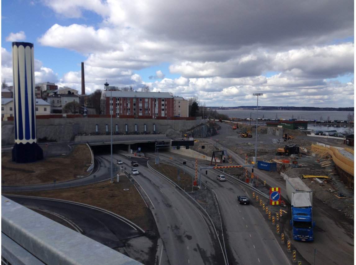
Kuva 9. Kekkosenkatu on siirretty maan alle louhittuun tunneliin.
