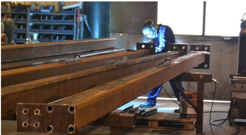
Kuva 29. Käsin hitsausta pukkien päällä.
