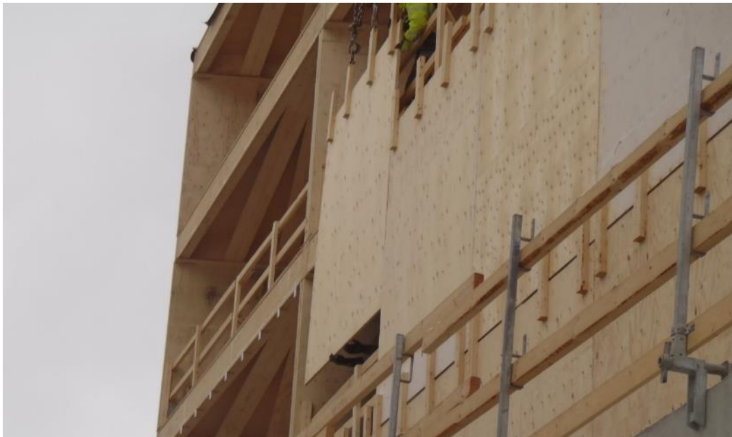
Kuva 4.6 Julkisivun kevyiden LVL-levyjen asennusta.
