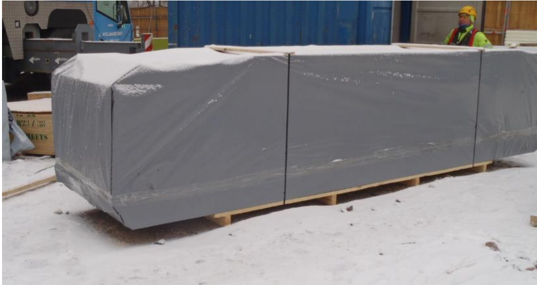
Kuva 4.4 Puuelementtien varastointia työmaalla suojattuna.
