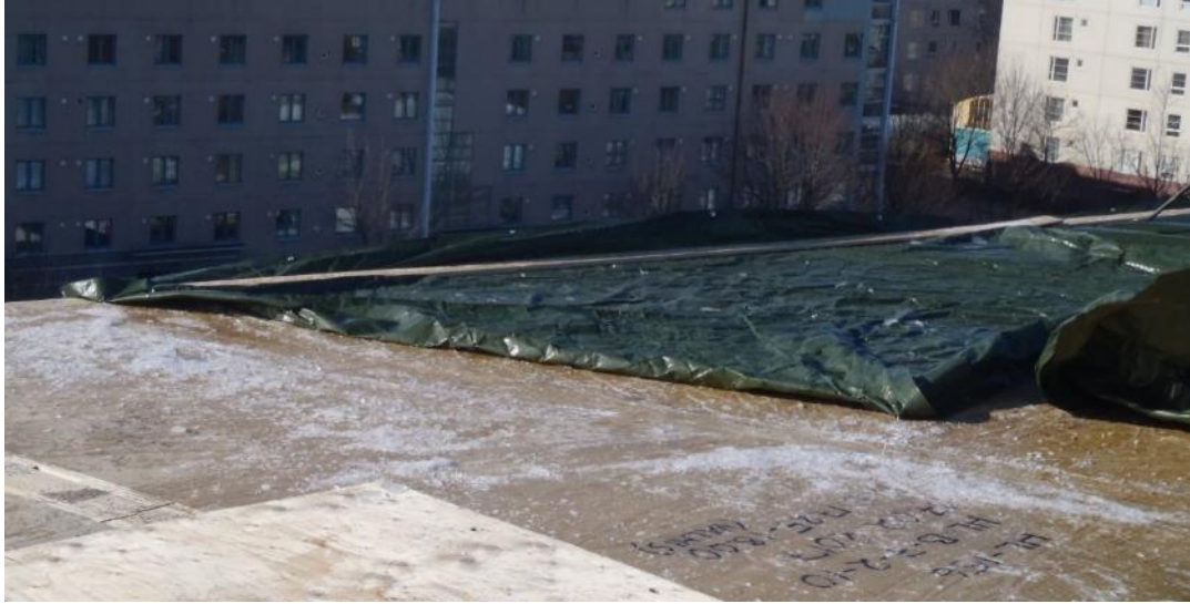
Kuva 4.7 Katon pressutusta laudoilla kiinnitettynä. Osa pressuista on jo poistettu etualalta.
