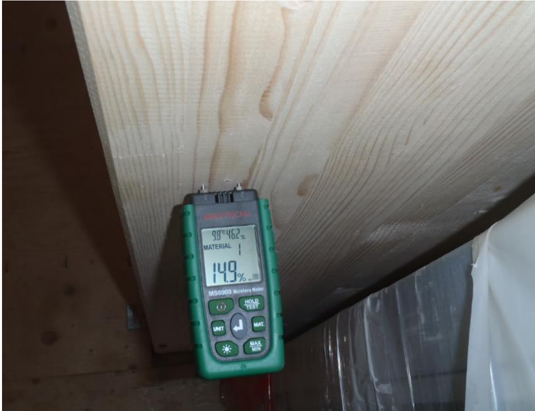
Kuva 3.4 Mastech-piikkimittari ja mittaus CLT-pilarista, josta saatiin oikean suuntainen tulos.
