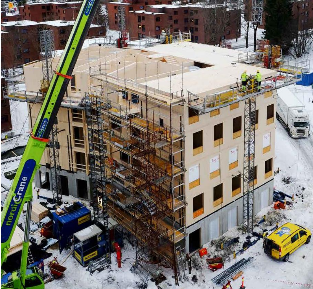
Kuva 2.7 Puukerrostalon rungon asennusta taivasalla Moholt 50/50 -projektissa (Kunø 2016).
