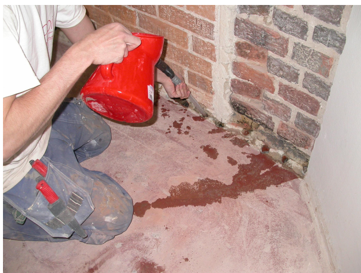
Kuva 4.11. Porareikäinjektointi valuttamalla (imeyttämällä).
