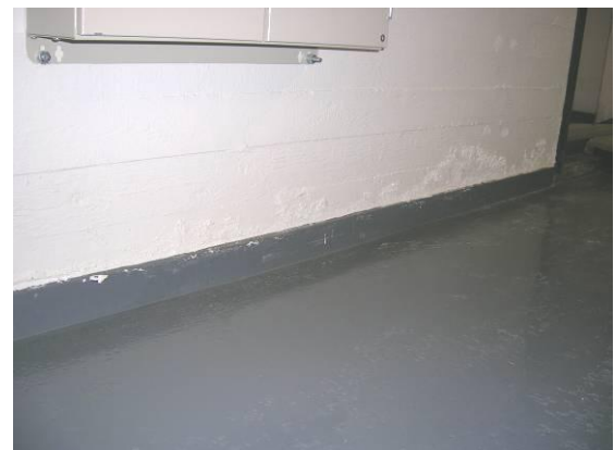
Kuva 3.29.- 3.30. Betoniseinän alaosaan on kiteytynyt suolaa alapohjan betonilaatan pinnoitteen ylösnoston yläpuolelle. Lattiapinnoitteena on tiivis epoksinnoite.
