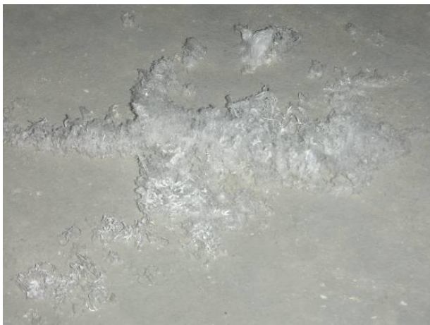
Kuva 3.42. Lattiapinnalle kiteytynyttä suolaa.
