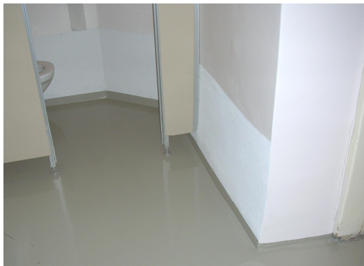
Kuva 4.5. Suolankeräyslaastirappausta on käytetty seinän alaosassa osittaiskorjauksena.
