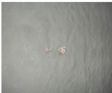
Kuva 4.7. Ruiskuttamalla asennettu vedentiivistyspinnoite, josta on tarkastettu kuivakalvonpaksuus. Tiivistyslaastit valmistetaan hyvin hienojakoisesta sementistä, mikä on nähtävissä valmiin pinnan sileytenä.
