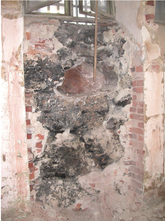
Kuva 3.2. Puretun tiilimuurauksen takana on nähtävissä vanha luonnonkivimuurauksen pintaan tehty vedeneristys. Rakennus on rakennettu 1880-luvun lopussa.
