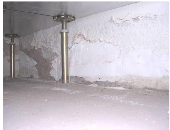
Kuva 3.27.- 3.28. Kosteuden mukanaan kuljettamat suolat kiteytyvät kosteuden haihtuessa. Seinissä on havaittavissa yhtenäisen haihtumisrintaman kohdalle syntynyt 1.suolakiteytymälinja. Linjan sijainti vaihtelee pääasiassa rakenteen kosteusrasituksen, kuivumiskyvyn ja suolojen koostumuksen mukaan.
