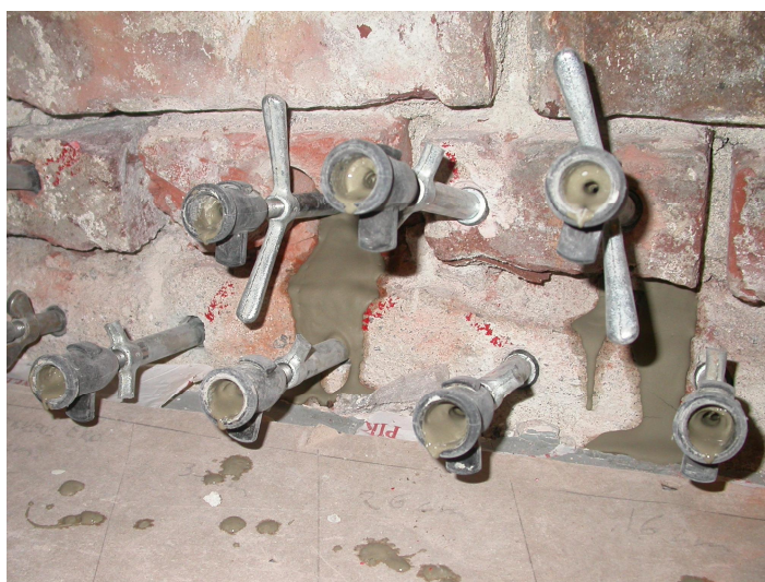
Kuva 4.14. Injektoinnissa käytettävät injektointitulpat eli pakkaajat. Paineellisesti injektoitu sementtilaasti on levinnyt muurauslaastissa ja tullut laastisaumojen epäjatkuvuuskohtien kautta rakenteen pinnalle.
