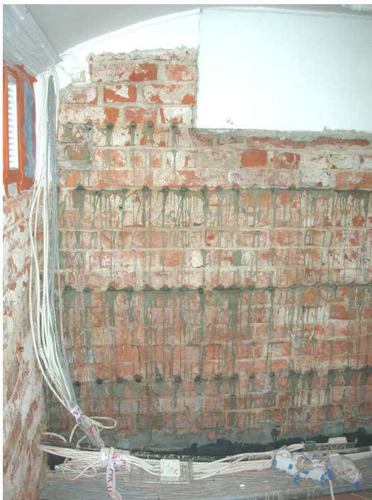
Kuva 4.16. Portaiden alla sijaitseva maanvastainen tiiliseinä on injektoitu valuttamalla injektointilaastia laastisaumojen kohdalta alaviistoon porattujen reikien kautta.
