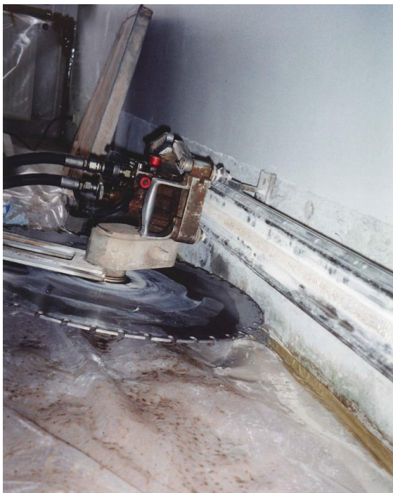
Kuva 4.9. V-leikkausmenetelmässä timanttisaha voidaan laittaa kiinni seinään asennettavaan kiskoon.
