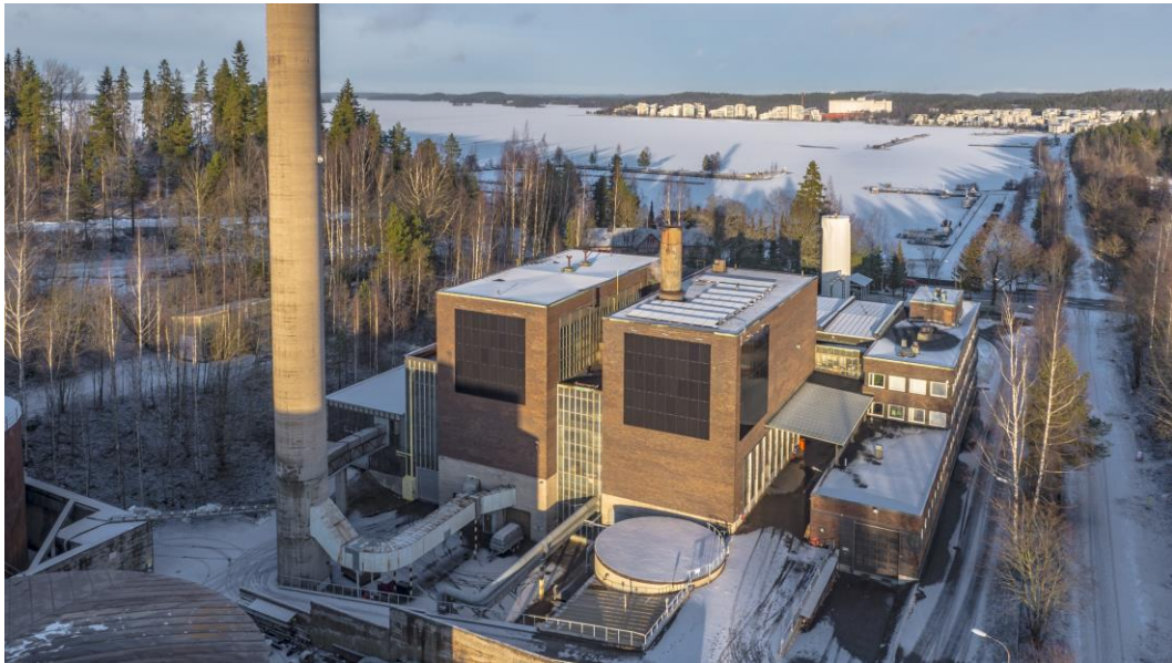
Kuva 6.3. Ilmakuva kiinteistöstä projektin valmistumisen jälkeen.
