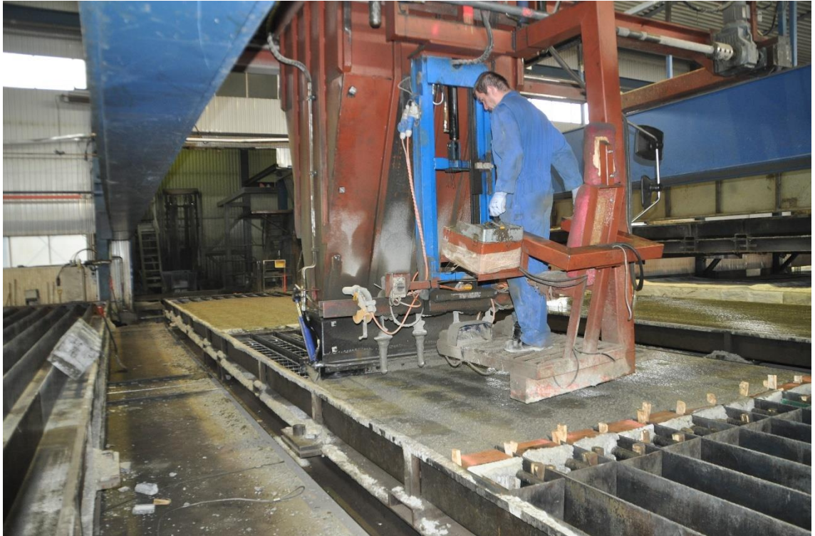
Kuva 5.5. Paalujen betonointilaitte ja betonoinnin suoritus.
