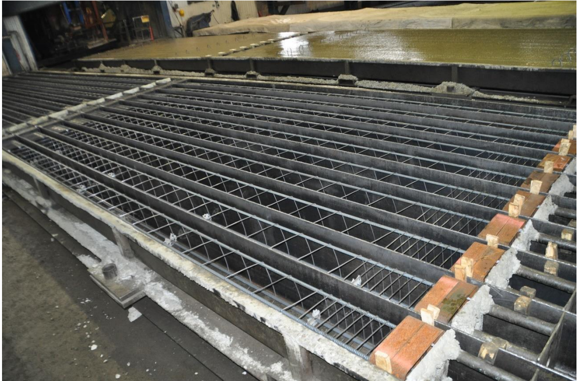
Kuva 5.3. Paalujen raudoittaminen paalutehtaalla.
