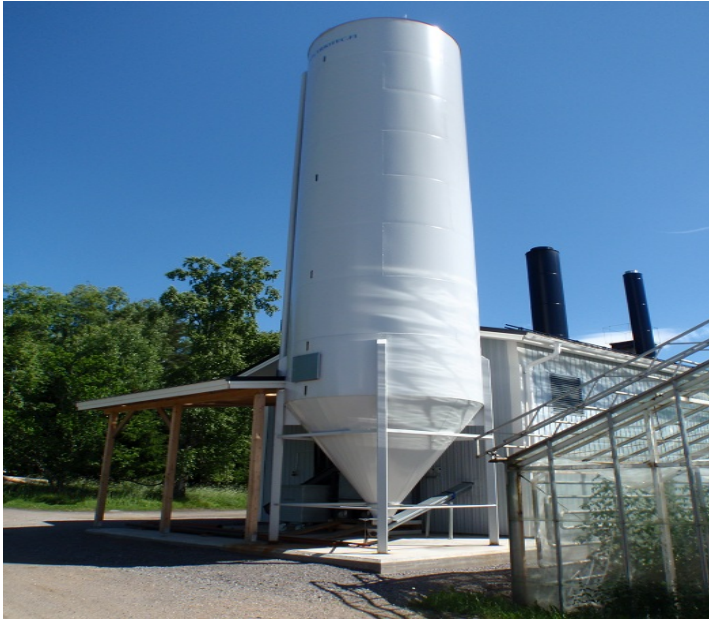
Kuva 4.7 Pystymallinen pellettisiilo (tilavuus 74 m 3 ) [30]
