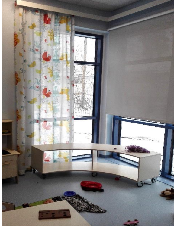
Kuva 12: Suuret ikkunat aiheuttavat ylikuumenemistä auringon paistaessa jo alkukevällä. Ongelmaa on pyritty vähentämään rullaverhoilla ja julkisivulla olevilla aurinkosuojilla.
