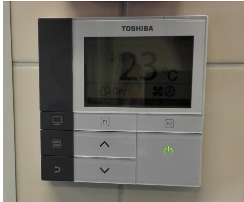
Kuva 16: Keittiön jäädytyksen ohjauslaite. Jäädytys on todennäköisesti ollut päällä rakennuksen valmistumisesta lähtien. Keittäjälle ei oltu koulutettu laitteen käyttöä eikä käyttöohjeita ollut saatavilla. Ennen kuvanottoa laite vaihdettiin jäädytykseltä kuivatukselle.
