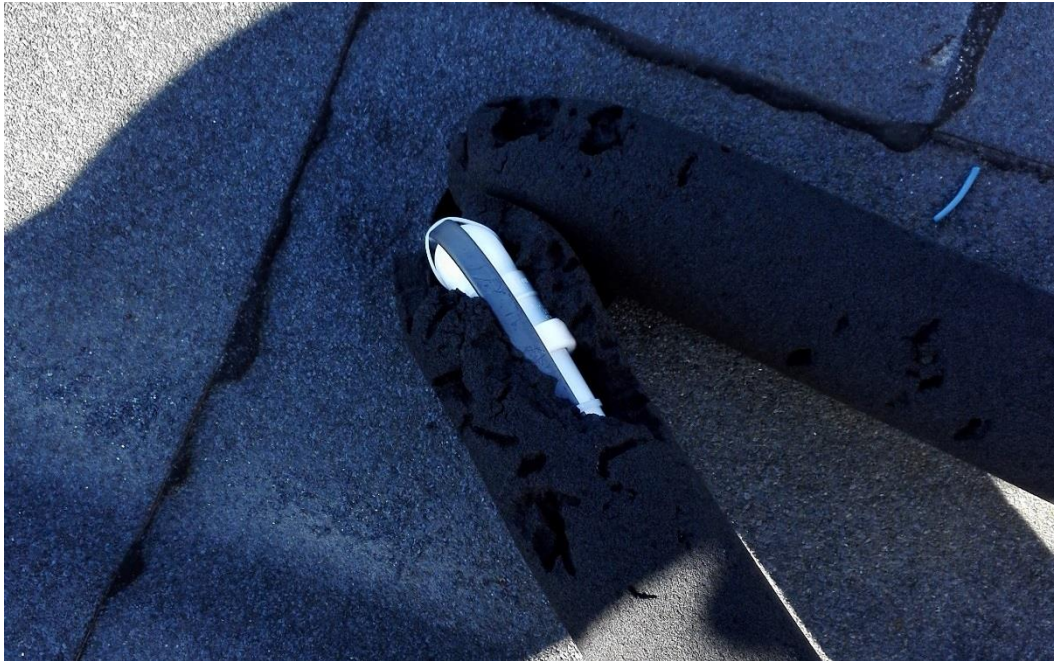
Kuva 21: Putken eriste oli auringon haurastama ja lisäksi linnut olivat nokkineet sen rikki.
