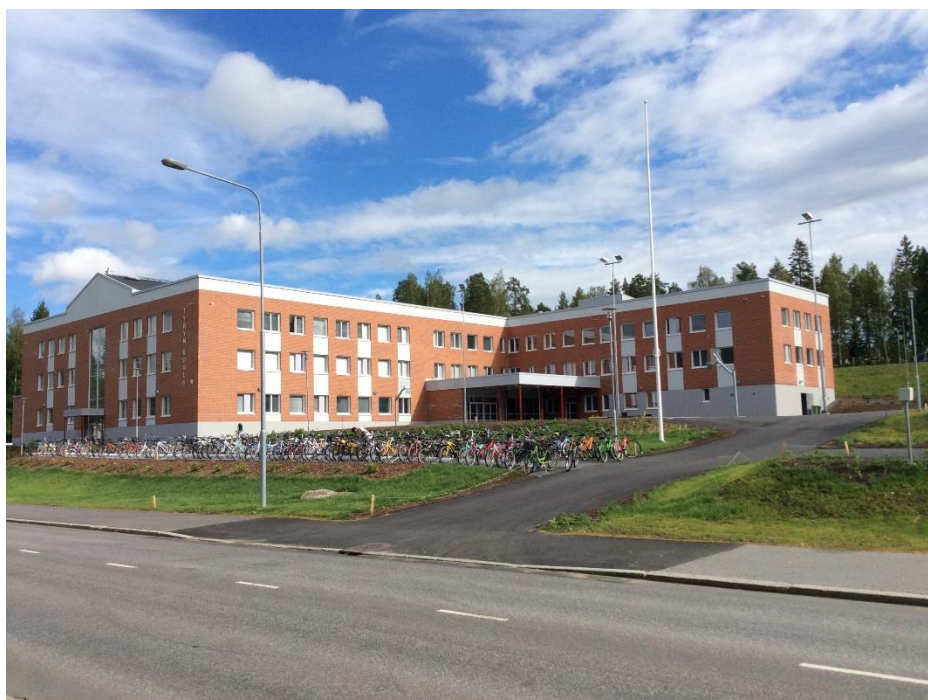
Kuva 17: Case B:ssä tutkittu koulurakennus.
