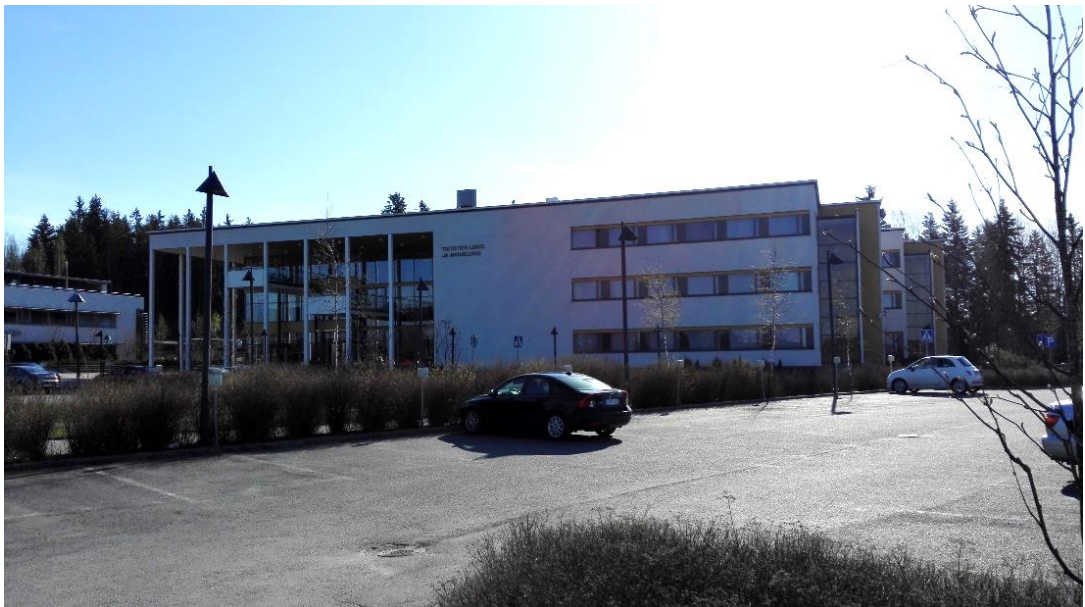
Kuva 24: Case C:ssä tarkasteltava rakennus kuvattuna teknisellä tarkastuskierroksella.
