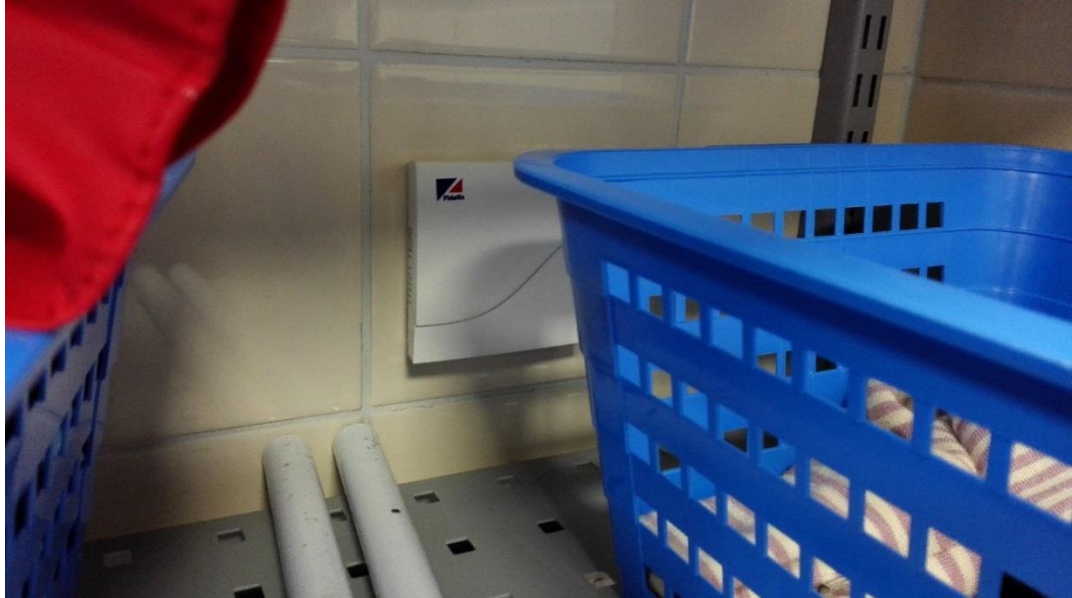
Kuva 15: Huonosti valittu lämpötila-anturin sijoituspaikka. Lisäksi vieressä oleva kuivauskaappi lämmittää nurkkaa, jossa anturi on.
