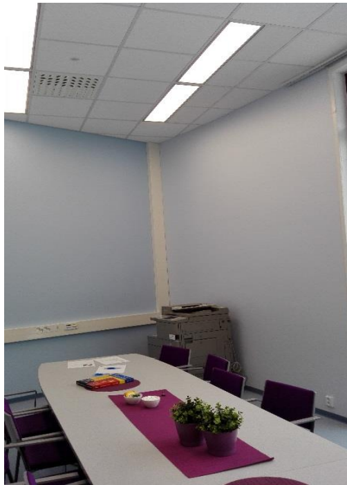
Kuva 13: Neuvotteluhuoneen ilmamääriä ei päästy tarkastelukierroksella mittaamaan, sillä tilaan pitäisi rakentaa telineet, jotta mittaukset päästäisiin ilmanvaihdon päätelaitteista tekemään.
