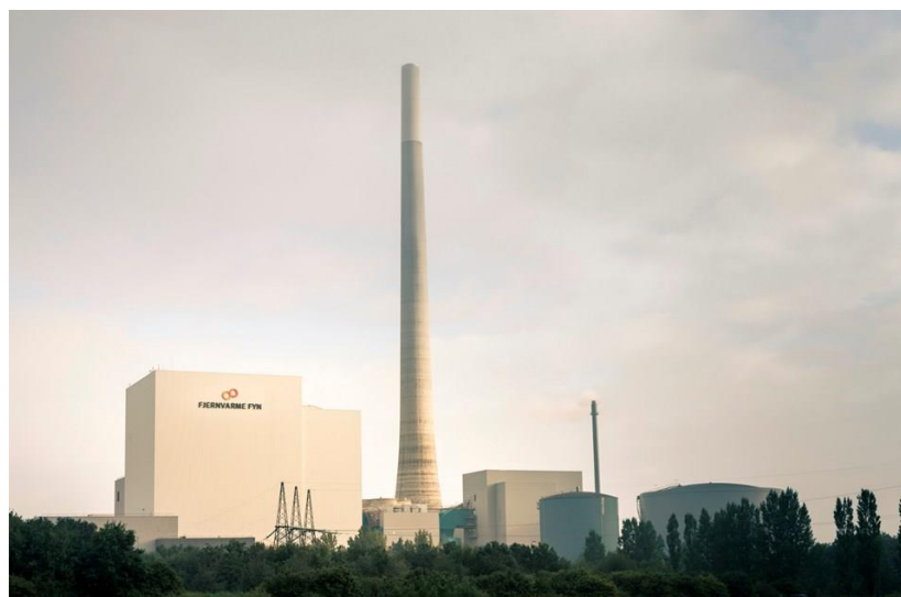
Kuva 16: Fynin voimalaitos. Lähde: Fjernvarmefyn.
