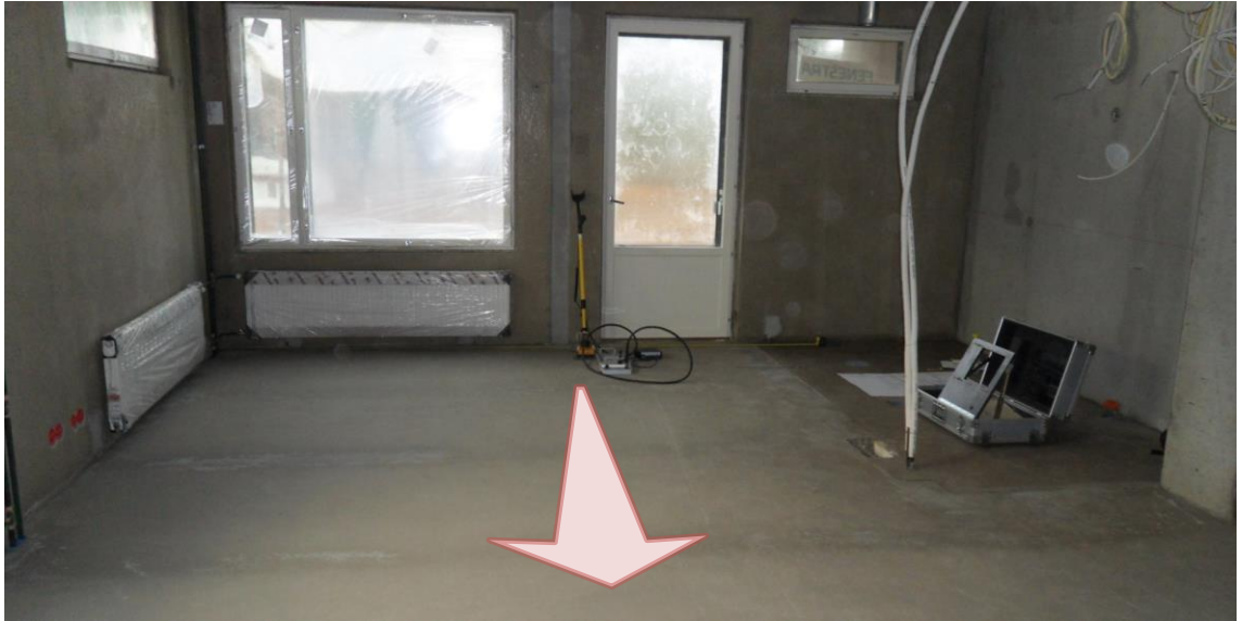
Kuva 4.3.2.b. Piirustukseen punaisella on merkitty huone sekä tutkalaitteisto. Tutkalaitteistoon kuuluu akku, näyttö sekä tutka. Työmaalla tutkan liikuttaminen onnistui kävelykeppityylisen jatkovarren avulla. Akku sopii työliivin taskuun ja näyttölaite kulkee mukana vapaassa kädessä. Tutkauksen helpottamiseksi laitteiston mukana kuljettamisessa on kehittämisen varaa. Ontelolaattavälipohjan päällä on lattiatasoite ja onteloiden vesireiät on avattu.
