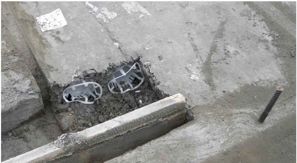
Kuva 2.1.1.b. Leikatun laatan onteloiden päät on pyritty tukkimaan muovisilla valutulpilla. (Työmaakäynti 30.10.2015.)
