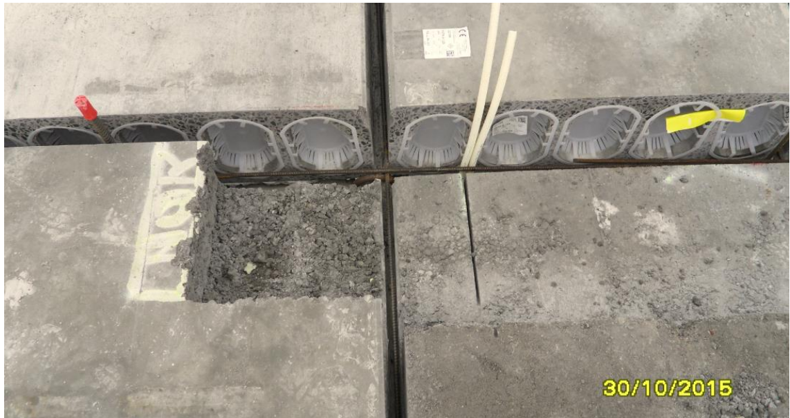
Kuva. 2.1.1.a. Ontelolaattojen päissä on valutulpat hyvin paikoillaan. (Työmaakäynti 30.10.2015.)
