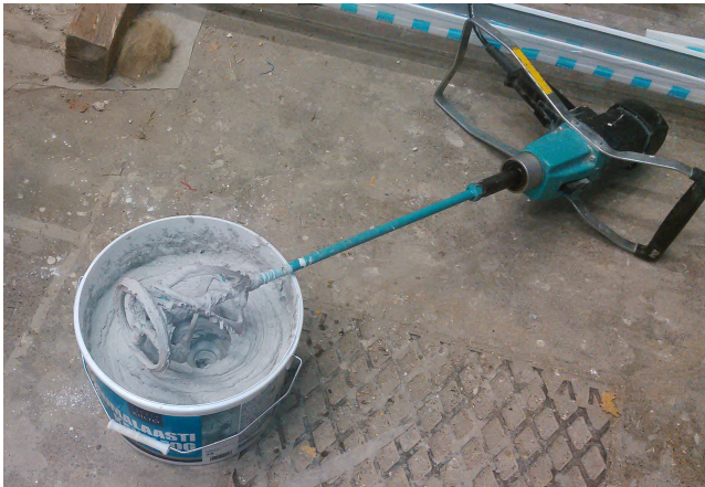
Kuva 4.3: Laastisekoittaja ja tavanomaisen saumalaastin valmistuserä.
