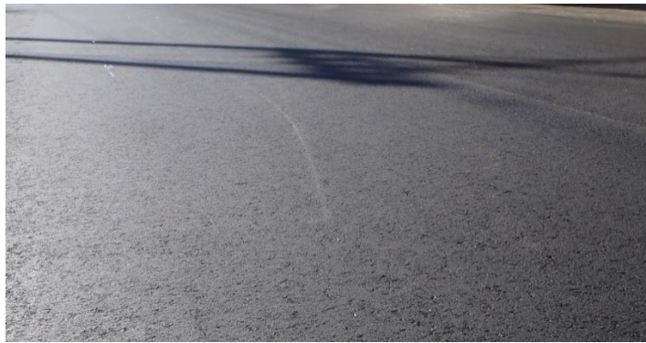
Kuva 6.13 Esimerkki hyvälaatuisesta päällysteosuudesta FEP -koeosuudella (Ylöjärvi, Jonna Rossi 2015)
