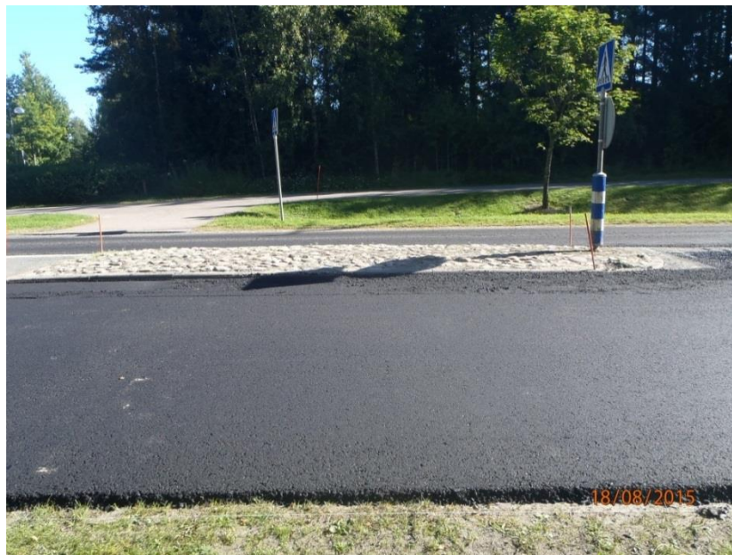
Kuva 6.9 Siironmaantien liittymän läheisen saarekkeen ympäristä ennen esijyräystä (Ylöjärvi, Jonna Rossi 2015)
