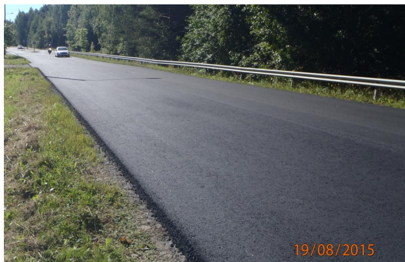
Kuva 6.14 Elastomeeripellettimodifioitu ja vertailupäällyste (Ylöjärvi, Jonna Rossi 2015)
