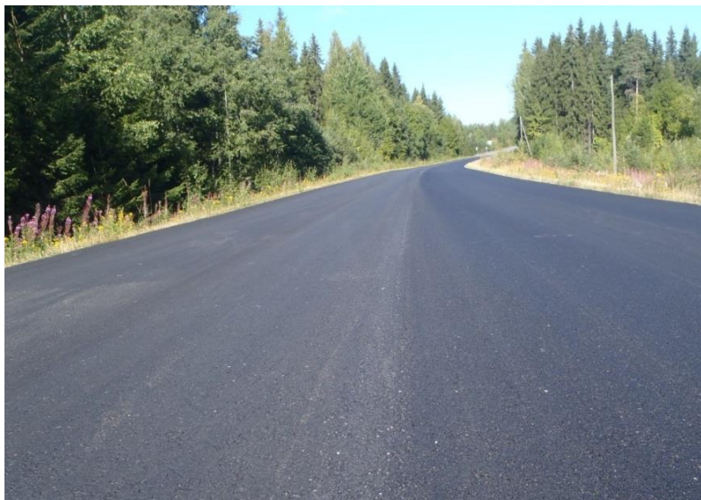
Kuva 6.20 HMA -kuitumodifioitu ja AB-päällyste (Ylöjärvi, Jonna Rossi 2015)
