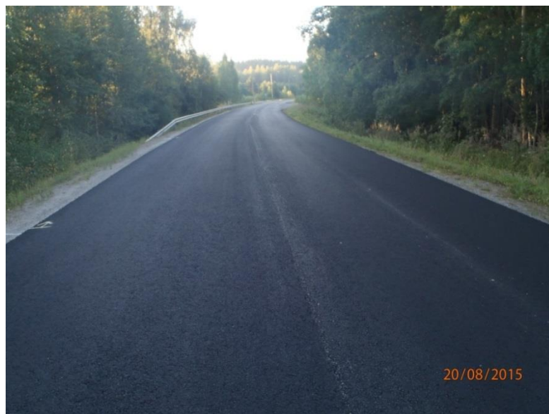
Kuva 6.17 Päällystenäytteiden ottopaikan kohdalla havaittu harva keskisauma (Ylöjärvi, Jonna Rossi 2015)
