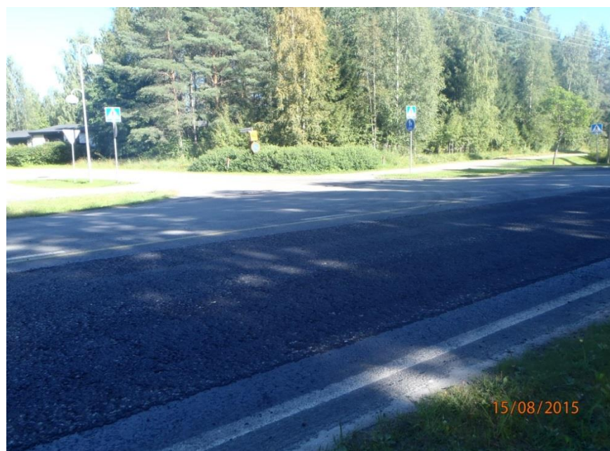
Kuva 6.4 Tyypillinen tien pinnan tasaus koekohteen loppuosuudella (Ylöjärvi, Jonna Rossi 2015)
