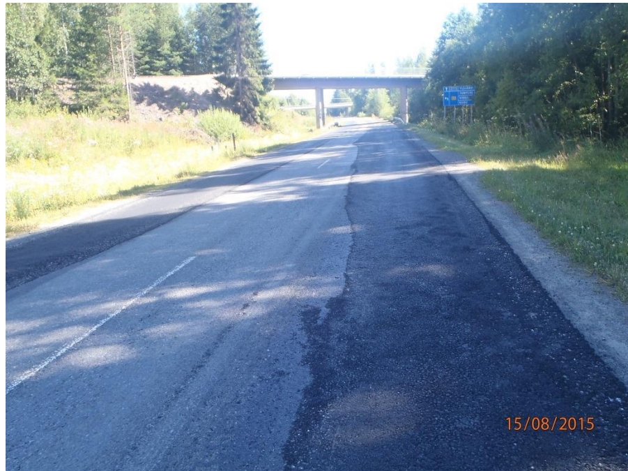
Kuva 6.3 Tyypillinen tien pinnan tasaus koekohteen alkuosuudella (Ylöjärvi, Jonna Rossi 2015)
