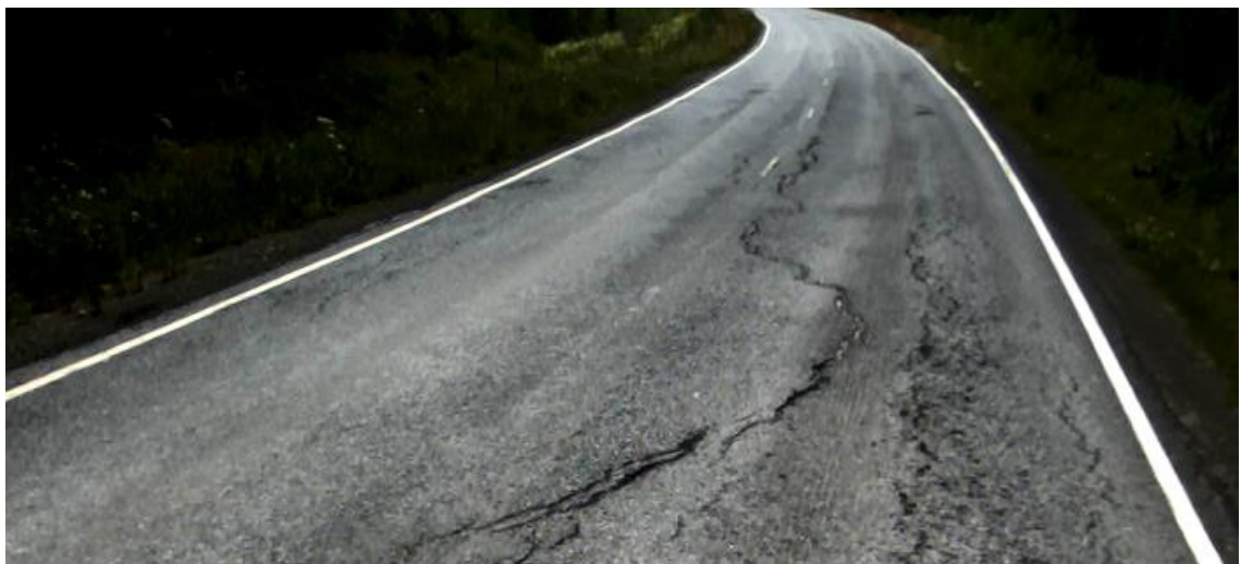
Kuva 5.3 Routahalkeama ja väsymishalkeamia 2773/4/6560 (Ylöjärvi, Jonna Rossi 2015)
