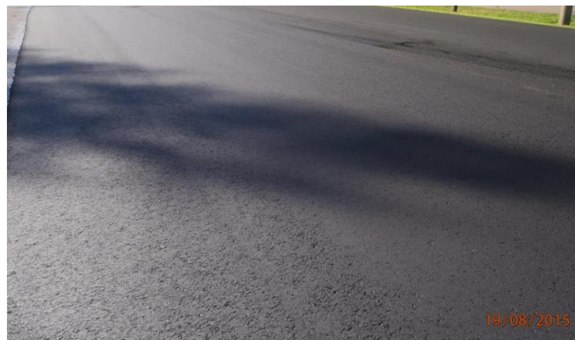
Kuva 6.12 Päällysteen pinnalla havaittu harvempi linja (Ylöjärvi, Jonna Rossi 2015)
