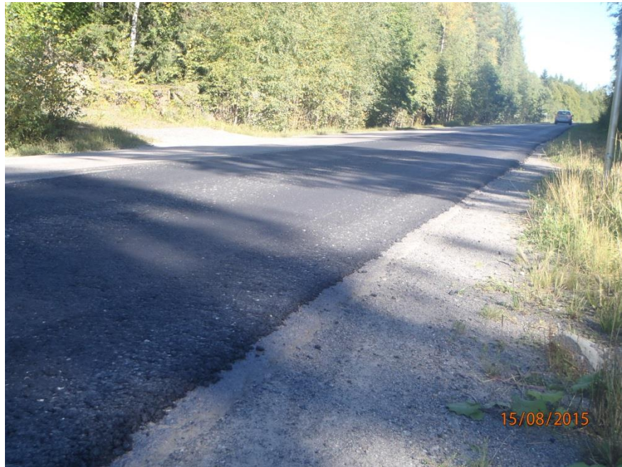
Kuva 6.5 Tien pinnan tasaus Vuorikalliontien liittymän lähetyvillä (Ylöjärvi, Jonna Rossi 2015)
