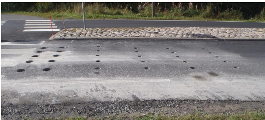
Kuva 7.32 Elastomeeripellettimodifioidun päällysteen näytteenottopaikka (Ylöjärvi, Jonna Rossi 2015)
