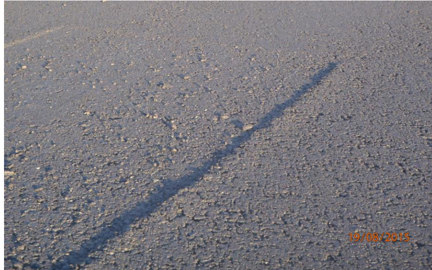
Kuva 6.10 FEP -koeosuuden alkupuolella havaittu asfalttimassan työstettävyysoongelma (Ylöjärvi, Jonna Rossi 2015)
