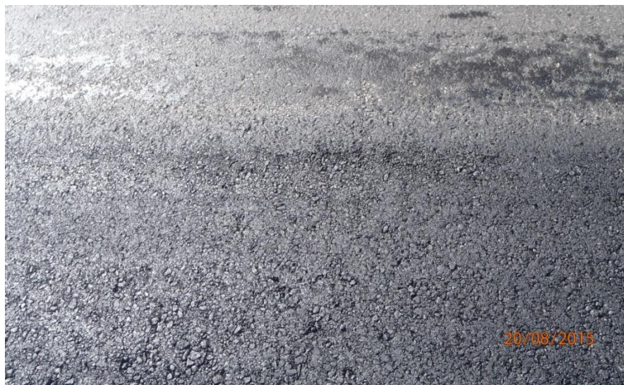
Kuva 6.22 Vastamäentien liittymän kohdalla havaittu harva keskisauma (Ylöjärvi, Jonna Rossi 2015)
