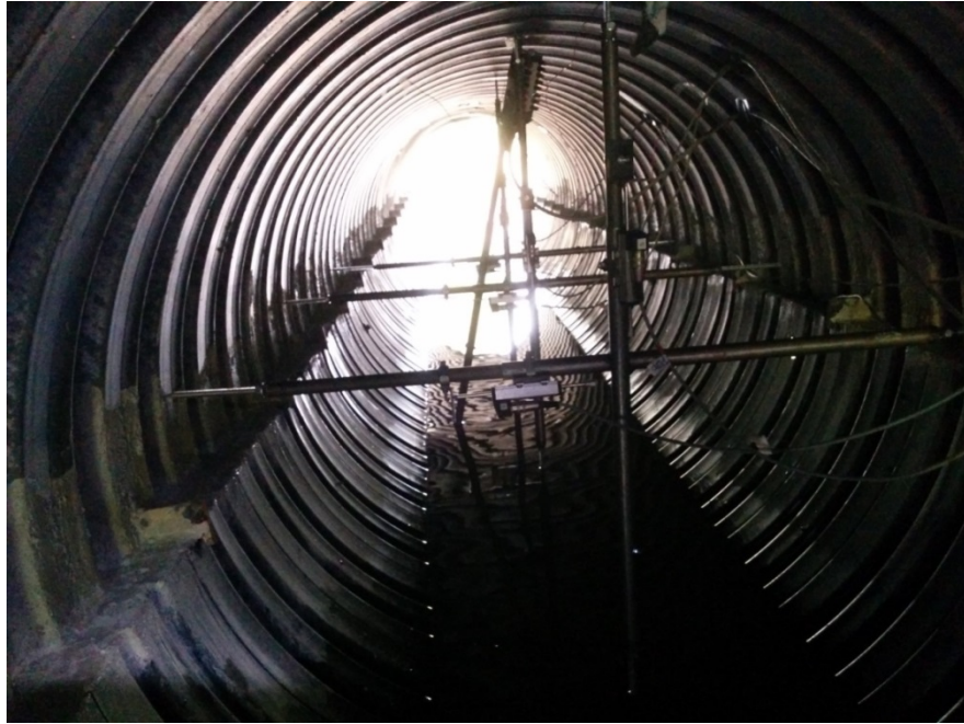
Kuva 18. Puolipohjauskohde instrumentoituna korjauksen jälkeen.
