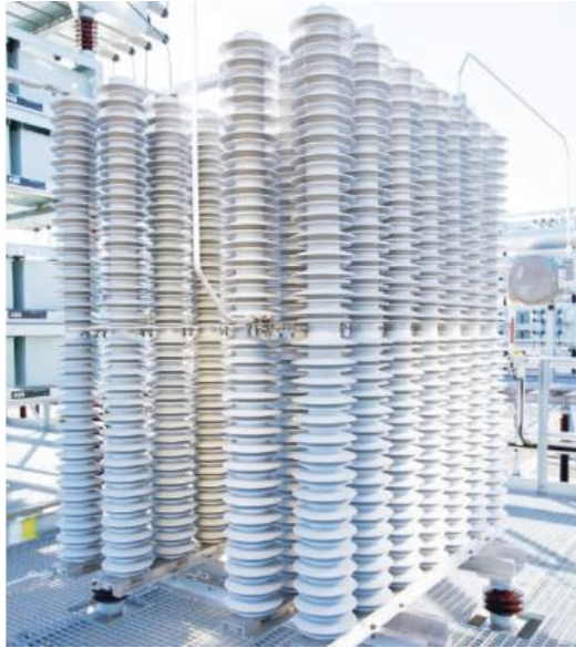
Kuva 3.3 Sarjakondensaattorin yhden vaiheen varistorit. [19]
