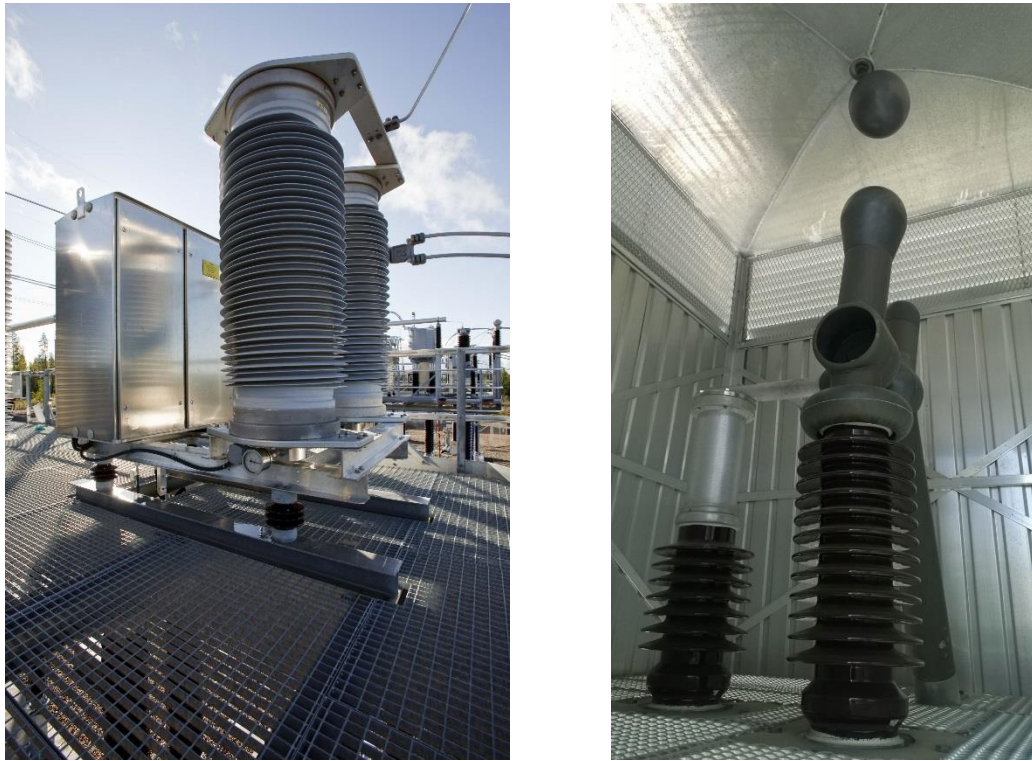
Kuva 3.4 CapThor-suojalaite vasemmalla ja perinteinen kipinäväli oikealla. [19]
