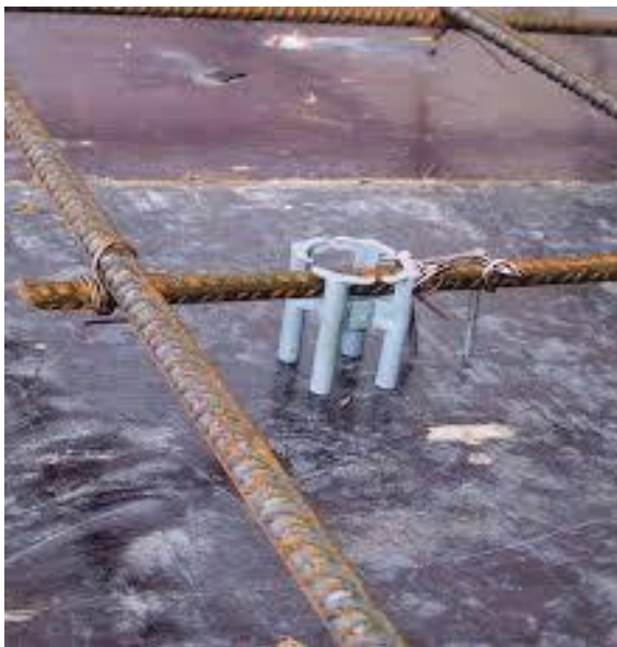
Kuva 4.1 Raudoitusvälike irtoteräsraudoituksen tukena
