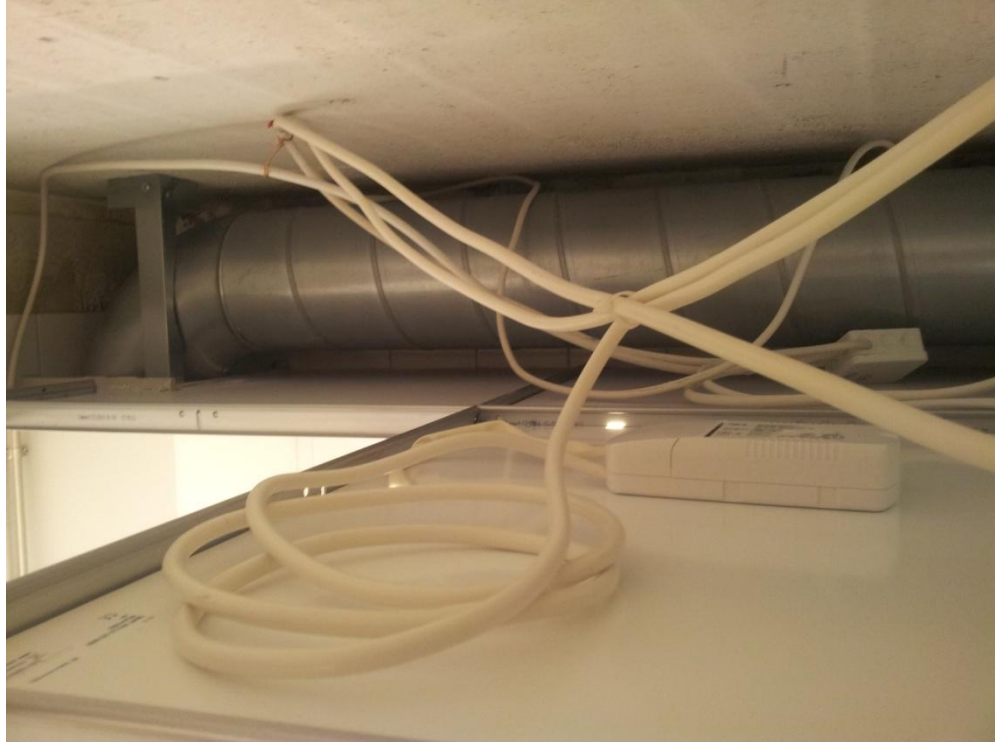
Kuva 28. Alakaton yläpuolisten tilojen dokumentointia
