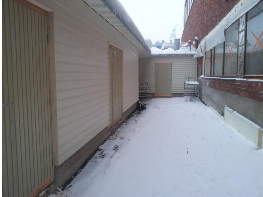
Kuva 18. Julkisivun villaeristeiden sääsuoja ennen pellitystöitä
