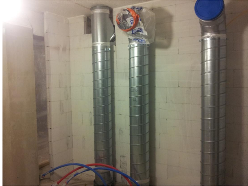
Kuva 12. Valmiit ilmanvaihdon asennukset suojattiin pölytiivisti
