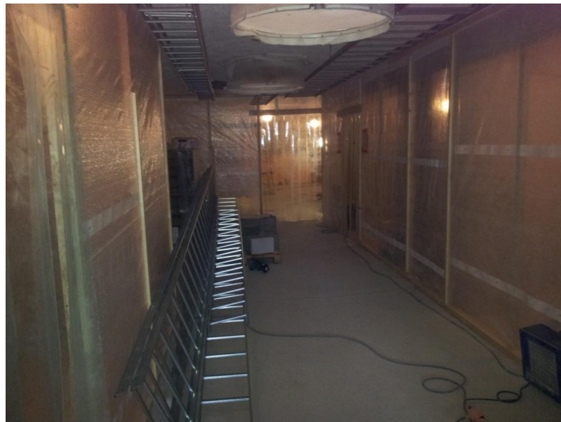
Kuva 13. Valmistuskeittiön ilmanvaihdon asennusalueiden jakoseiniä
