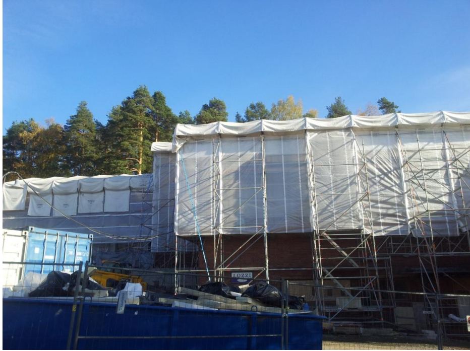
Kuva 16. Julkisivusuojia käytettiin sadevesien ohjaamiseen ikkunakunnostustyön aikana
