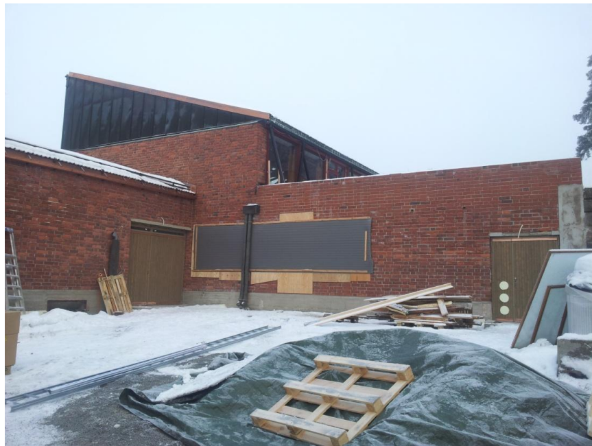
Kuva 17. Väliaikainen ikkuna-aukon suojarakenne
