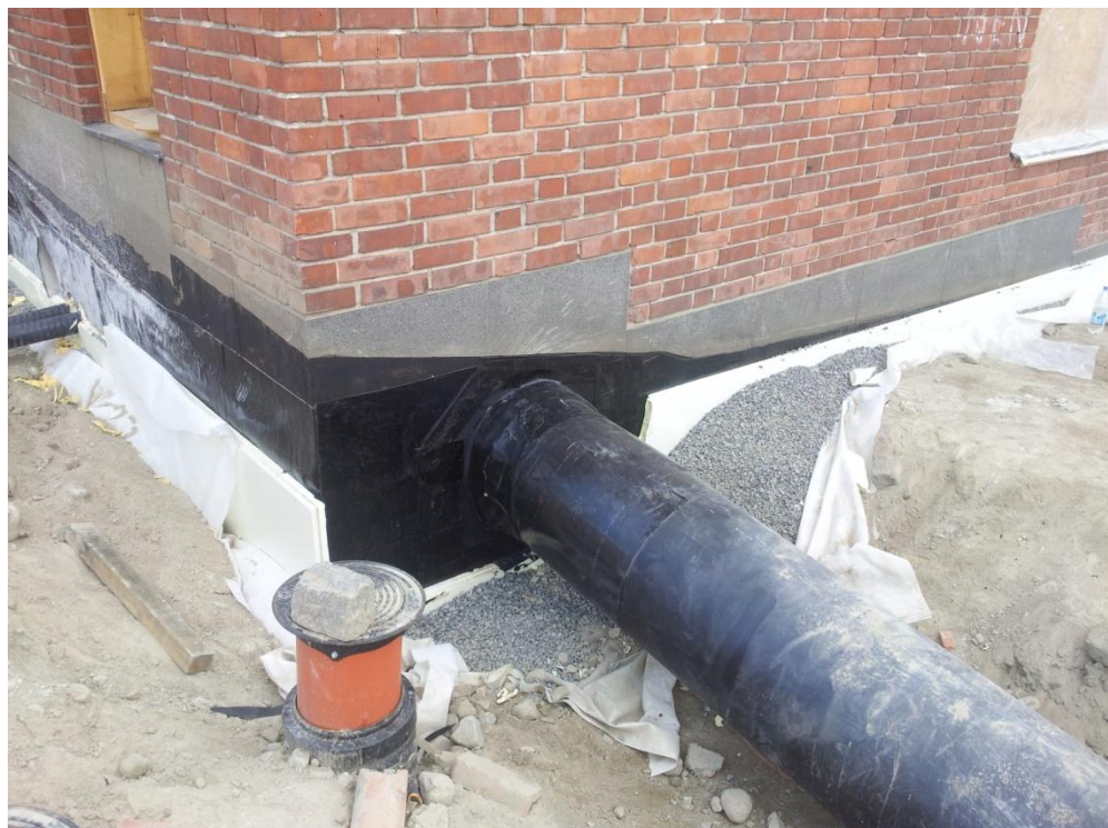
Kuva 19. Perusmuurin ja läpiviennin vedeneristystä
