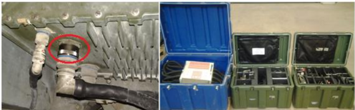
Kuva 3. Järjestelmään kytketty vikaliitin ja diagnostiikan välineistöä.
