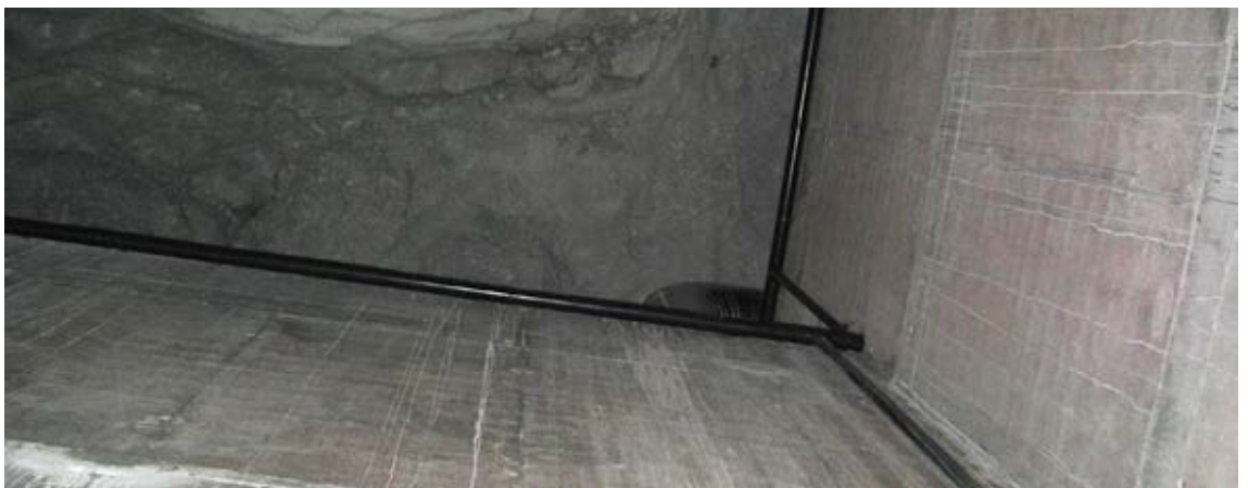
KALLION TIPPUVESIÄ VARTEN ON RAKENNETTU RÄNNIT
