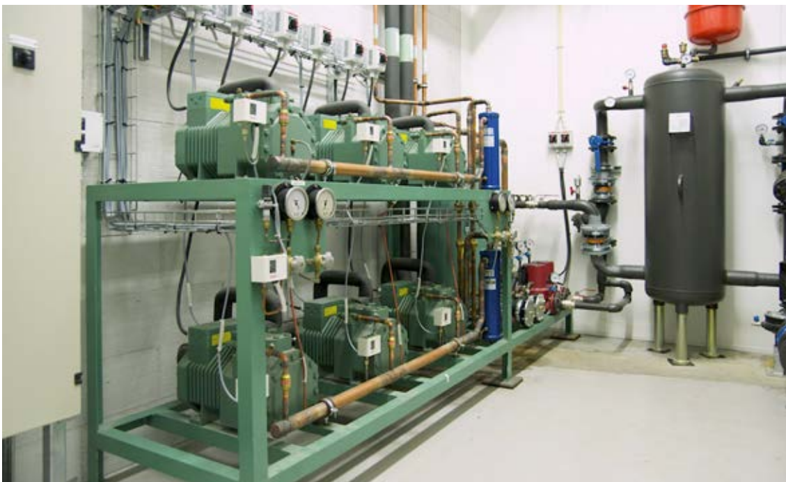
TYYPILLINEN KYLMÄ- KOMPRESSORI- PATTERISTO. GLOSTRUP, TANSKA.
