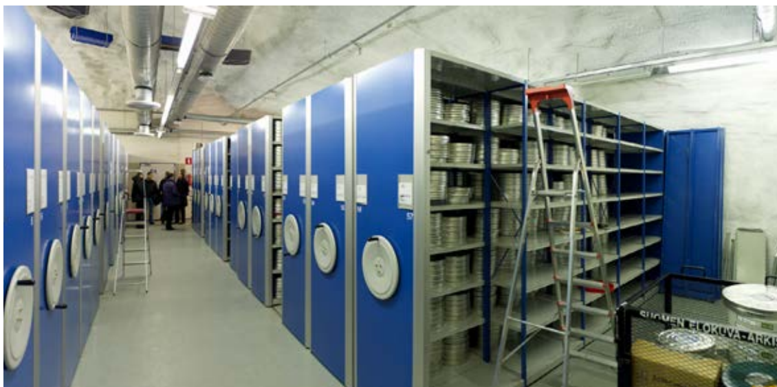
ENSIMMÄISESSÄ OTANIEMEN VARASTOSSA OLI KALLION MUOTO ESILLÄ ARKISTOTILOISSAKIN. HUOMAA TIPPUVESIKAUKALOT KATOSSA.
