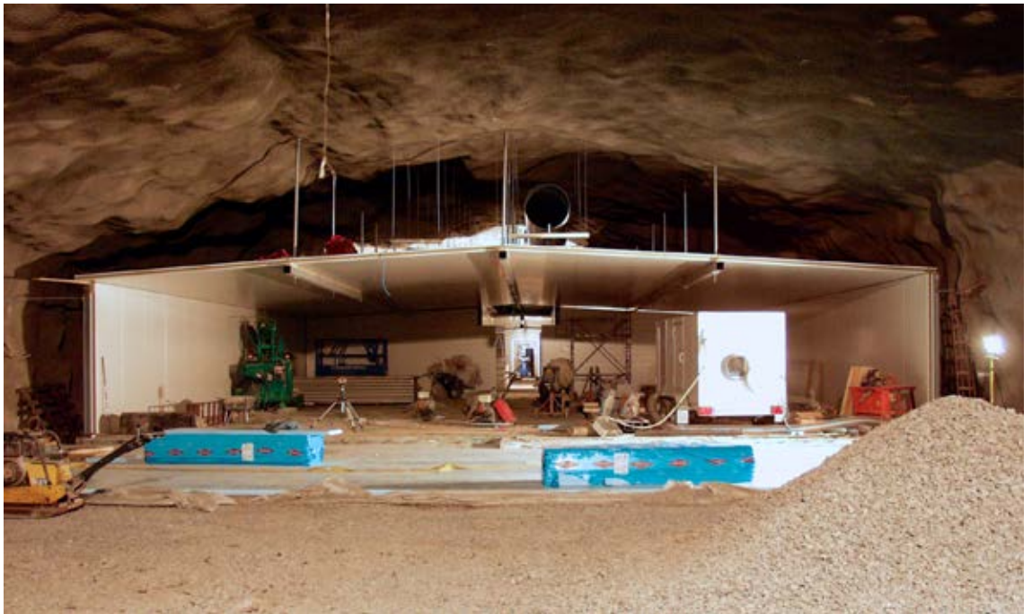
KYLMIÖRAKENNE ETENEE LUOLASSA
