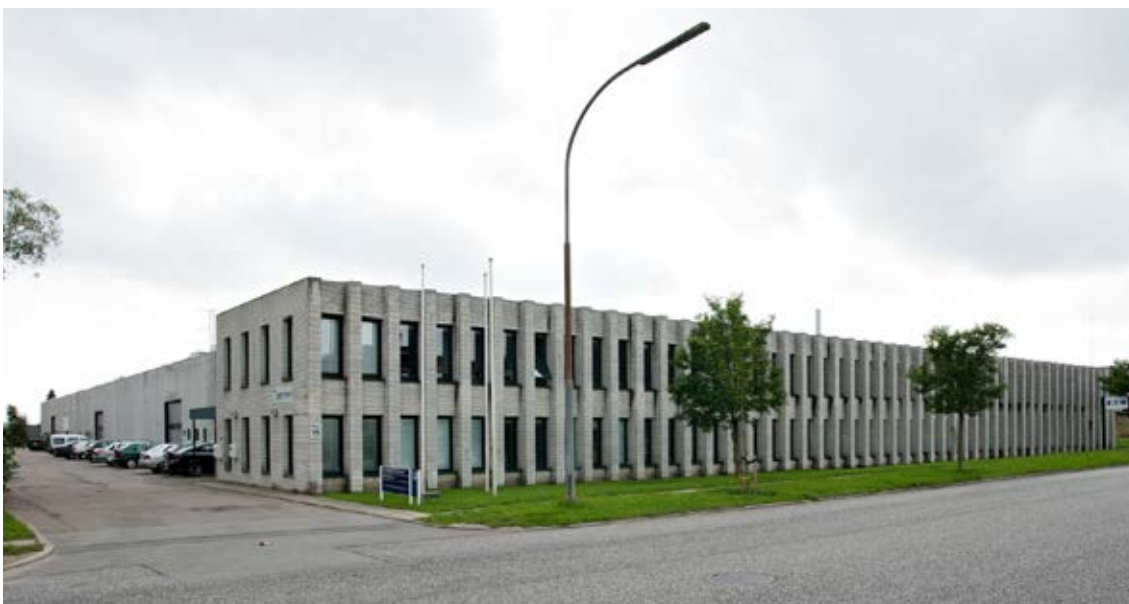
1970-LUVUN VARASTO- ARKKITEHTUURIA
