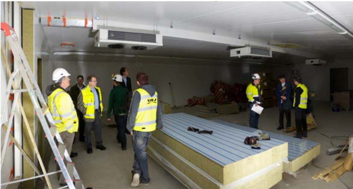
KATSELMUS UUDEN PAKKASVARASTON TYÖMAALLA
