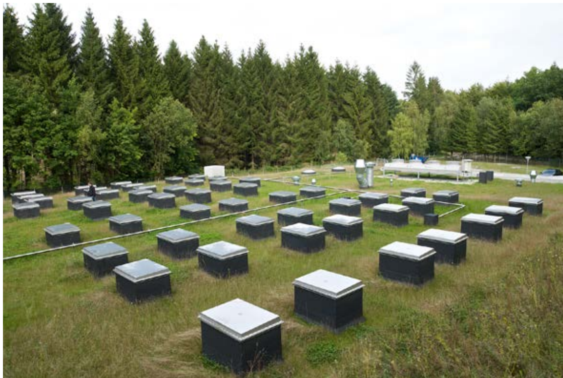
SIILOJEN KAASUPURKAUS- LUUKUT VARASTON KATOLLA
