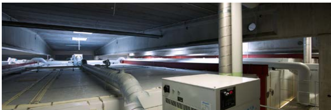
ARKISTOTILOJEN YLÄPUOLINEN VÄLITILA. OIKEALLA NÄKYVÄT ERI TILOJA PALVELEVAT KUIVAIMET
