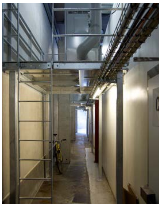
HYLLYSTÖN ALLA NÄKYY ASENNUSLATTIA, JONKA SISÄLLÄ KULKEVAT KISKOT
