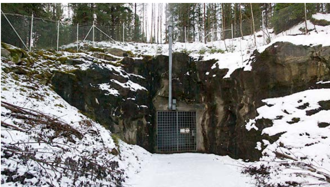
SISÄÄNKÄYNNISSÄ ON ULOIMPANA LIESKAT LÄPÄISEVÄ KALTERIOVI
