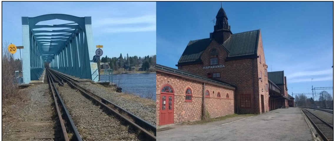
Kuva 22. Vasemmalla Suomen ja Ruotsin rajalla oleva silta Ruotsin puolelta kuvattuna ja oikealla Haaparannan rautatieasema.
