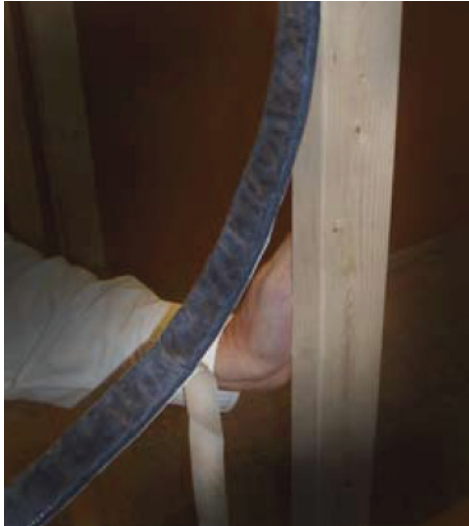
Kuva 3.24 Liimattavan Spaceloft-eristeen asentaminen runkotolppaan (vasemmalla). Oikealla lämpökamerakuva samasta rakennuksesta, jonka yläkerran runkotolppiin on asennettu Spaceloft-eriste. Alakerrassa runkotolpissa ei ole käytetty kylmäsiltoja katkaisevaa eristettä. (Aspen Aerogels)
