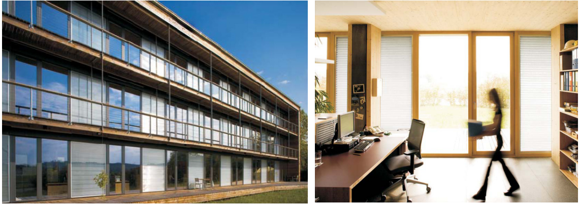
Kuva 4.26 GLASSX® crystal -lasielementit asennettuna saksalaiseen toimistorakennukseen. Vasemmalla näkymä ulkoa ja oikealla sisältä. (GLASSX AG)
