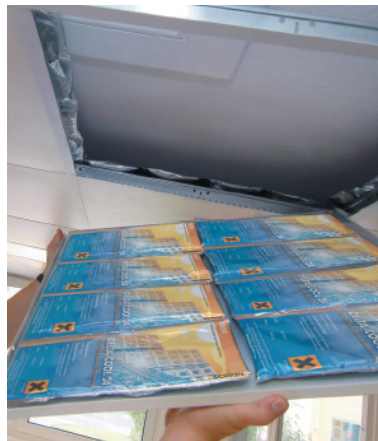
Kuva 4.30 Dörkenin DELTA ® -COOL 24 pussien asentaminen alaslaskettuun kattoon. (Dörken GmbH)
