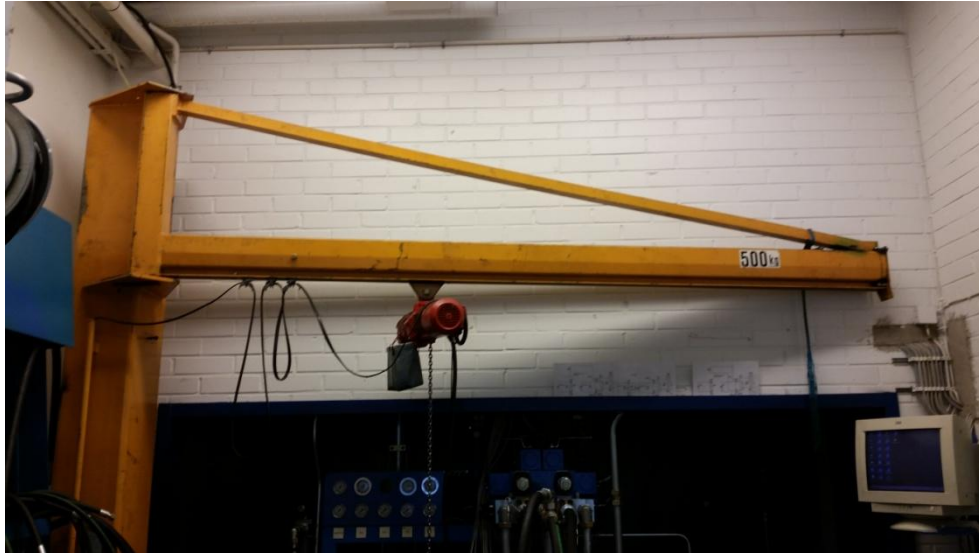
Kuva 5.21. Testipuolella takanurkassa sijaitseva nosturi.
