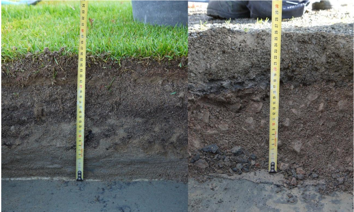
Kuva 7.12 Kuhmoisten urheilukentälle tehtyt koekuopat rakennetutkimusta varten
