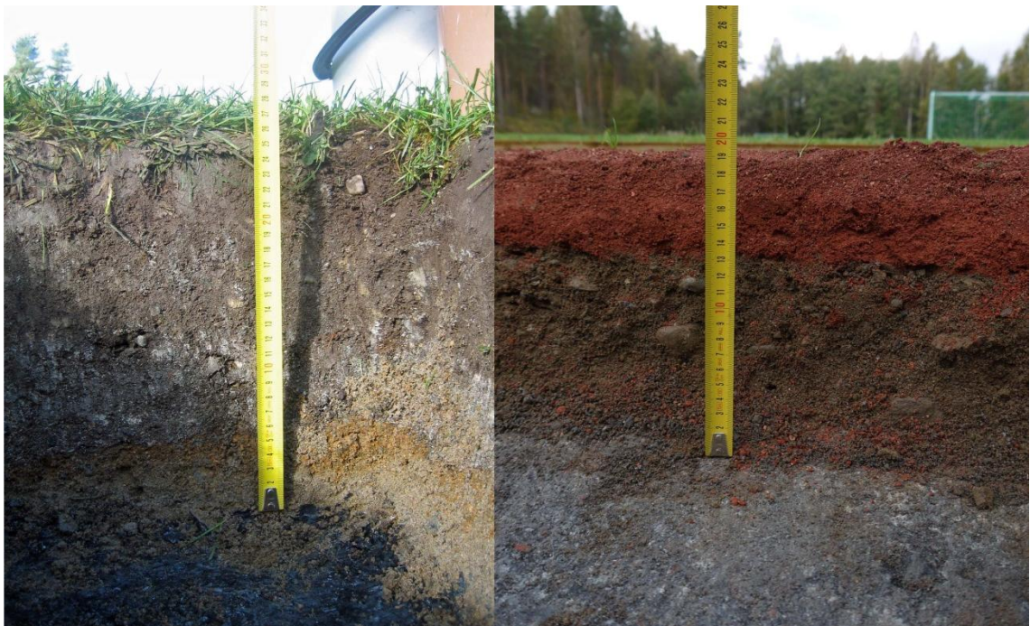
Kuva 7.17 Kuitutuhkan päällä olevat rakennekerrokset
