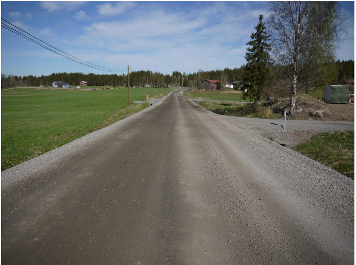
Kuva 7.8 Näkymä paalulta 2950, tien rakenne on erinomaisessa kunnossa vuosi rakentamisen jälkeen (16.5.2013) (Mäkinen, 2013)
