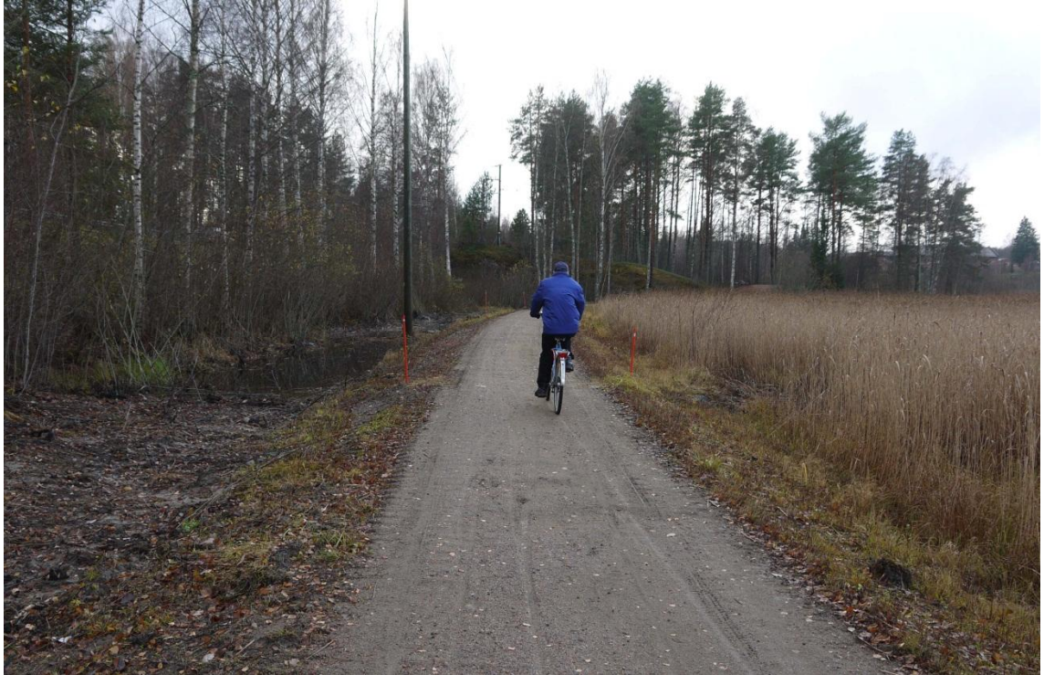
Kuva 7.6 Näkymä rantaosuudelta. Tien rakenne on kunnossa, mutta kulutuskerros pehmeä ja ojat täynnä vettä (25.10.2013)
