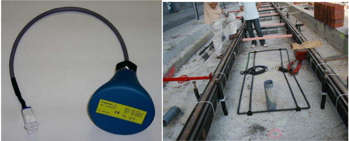
Kuva 47 Raitiovaunun On-Board-antenni ja raitiotielle asennettava silmukkailmaisim (Alstom 2012a)
