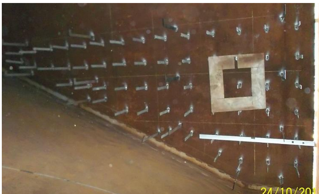
Kuva 3.3. Merkintöjen ja hitsauksien käytännön toteutus työmaalla. (AG Port Oy)
