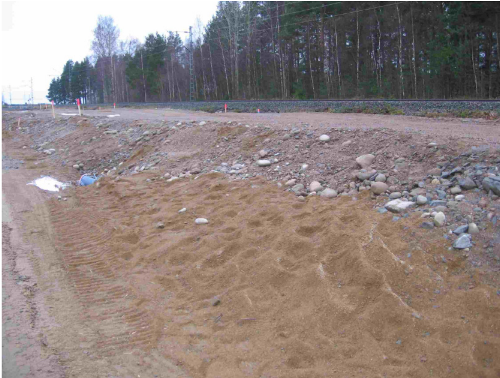
Kuva 6.2. Hipin sorarakenne rakentamisen jälkeen syksyllä 2009.
