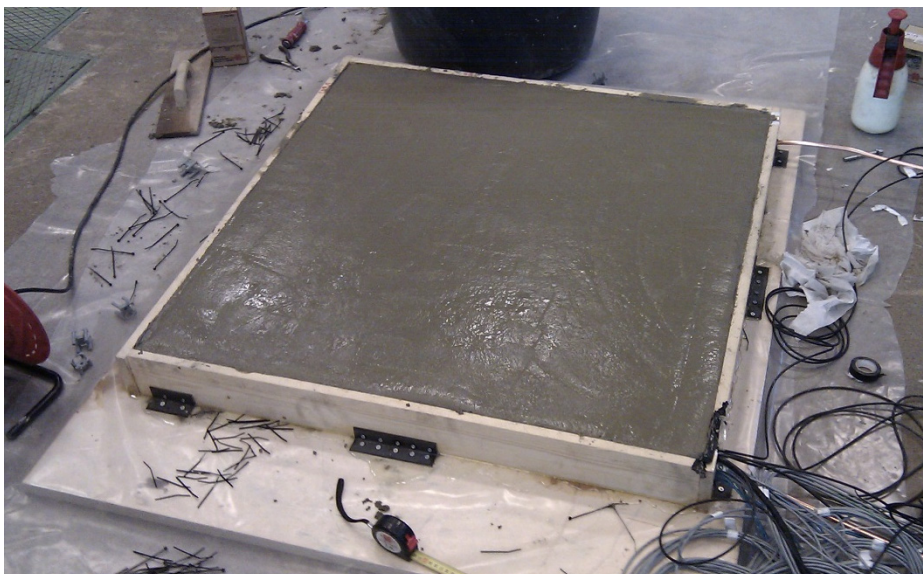
Kuva 4.12. Alalaatan valu valmis. Laatan päälle tulee vielä alumiininen kaukalo, joka hierrettiin paikalleen valun ollessa vielä kostea. Kuvan oikeassa alakulmassa näkyy varsin massiivinen johtonippu, joka menee laattaan.
