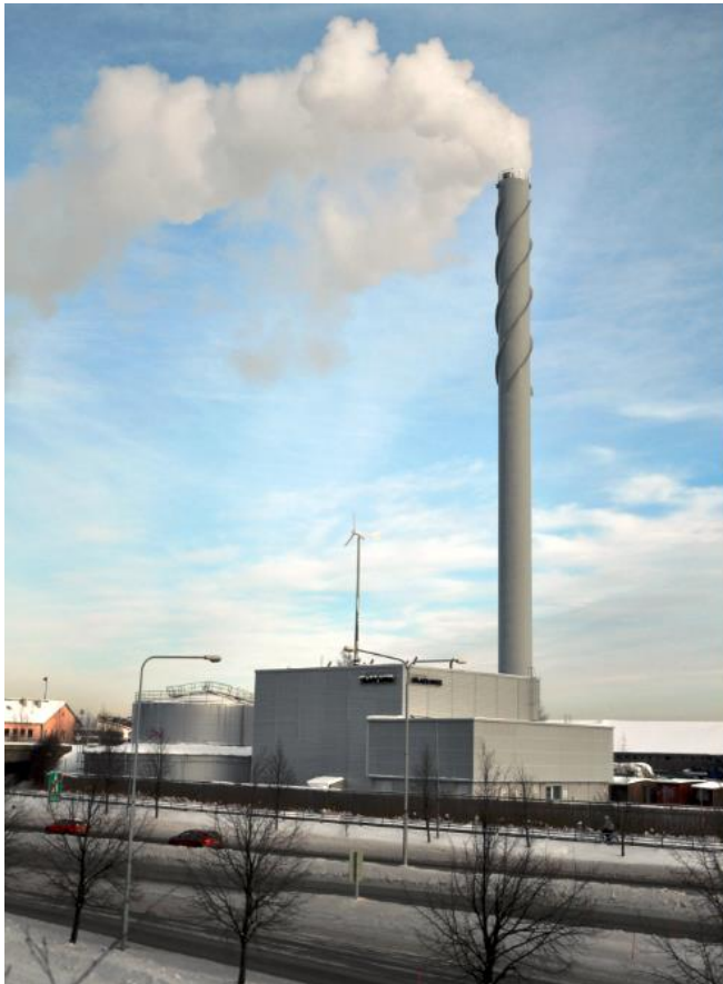
Kuva 5.5. Nekalan tuulivoimala kuvattuna koilliseen päin
