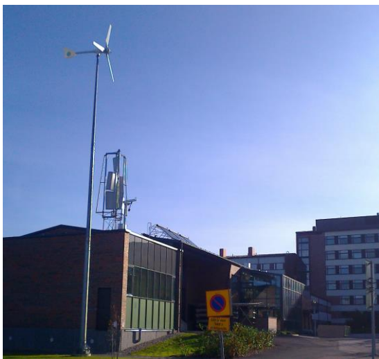
Kuva 5.1. Kaleva, TAMK:n tuulivoimala kuvattuna itään päin
