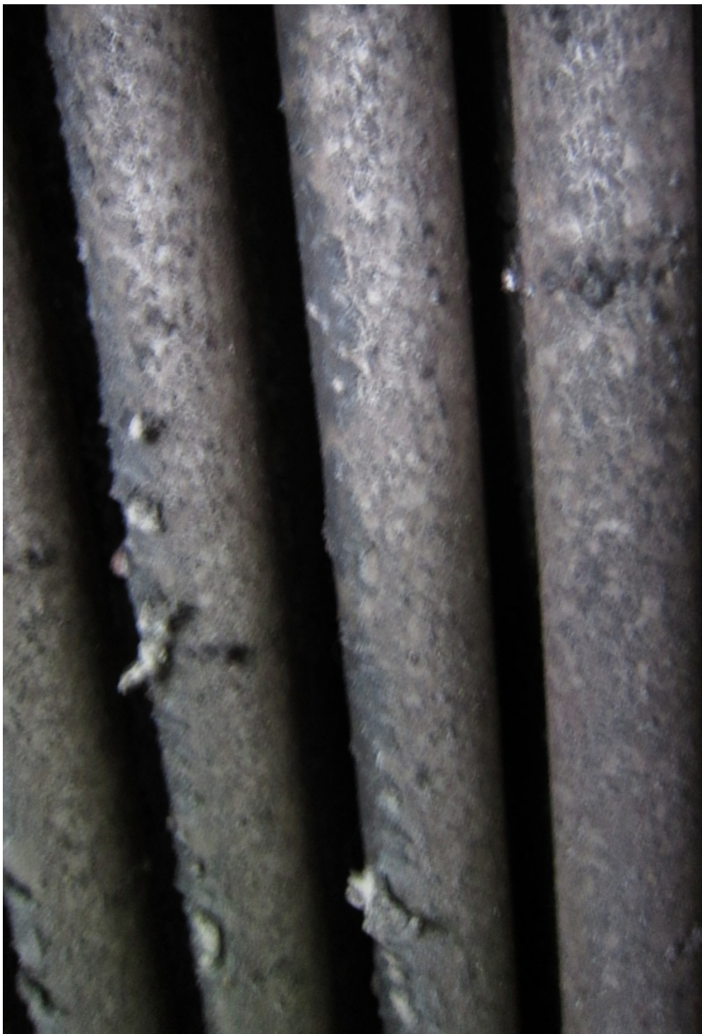
Kuva 15. 05WPLTO02-LTO patteri likaiselta puolelta.
