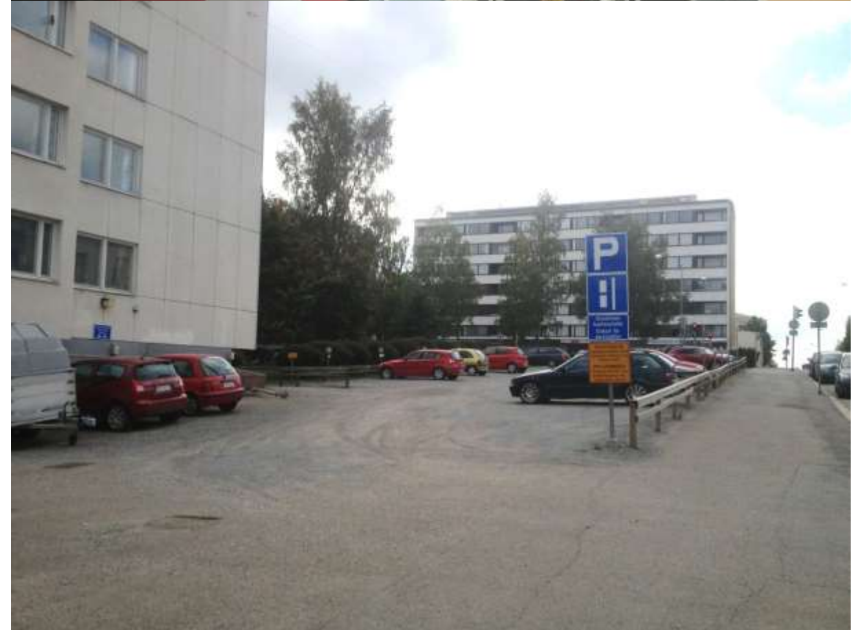
Yllä: Julkisivujen huonoa kuntoa.
