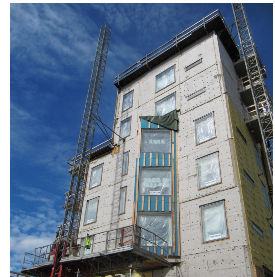
Kuva 2.3. Muutuskortit työmaalla, Asunto Oy Helsingin Sumujensilta.
